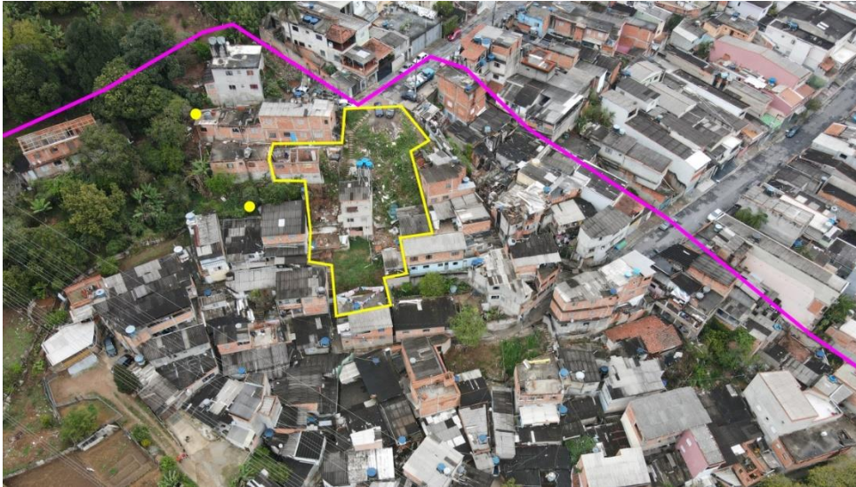
Figura 10. Exemplo de foto oblíqua obtida por voo de drone em São Bernardo do Campo, com pré-setorização e pontos críticos observados em escritório que permitem organizar roteiro de campo e otimizar a investigação em escala de detalhe. Fonte: LabGRis, 2020.
