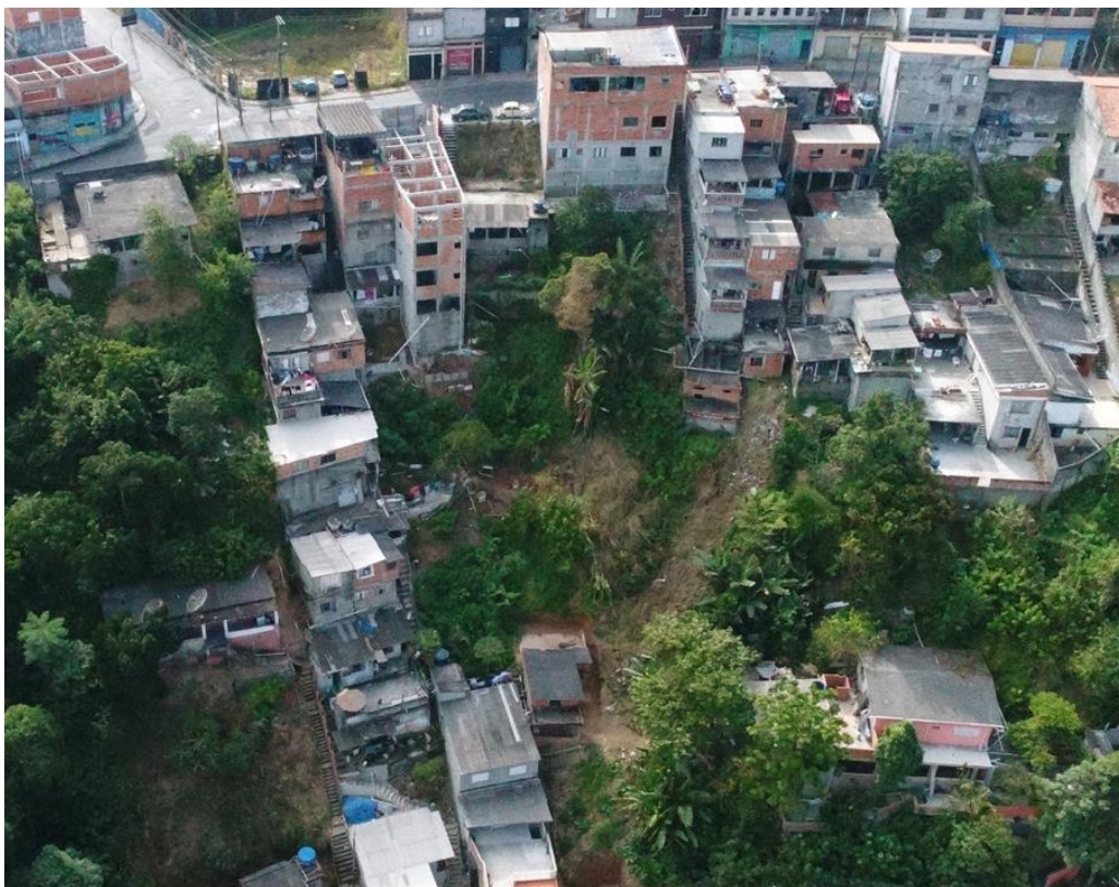
Figura 8. Detalhe de ampliação de imagem oblíqua obtida por voo de drone. Fonte: LabGRis, 2020.
