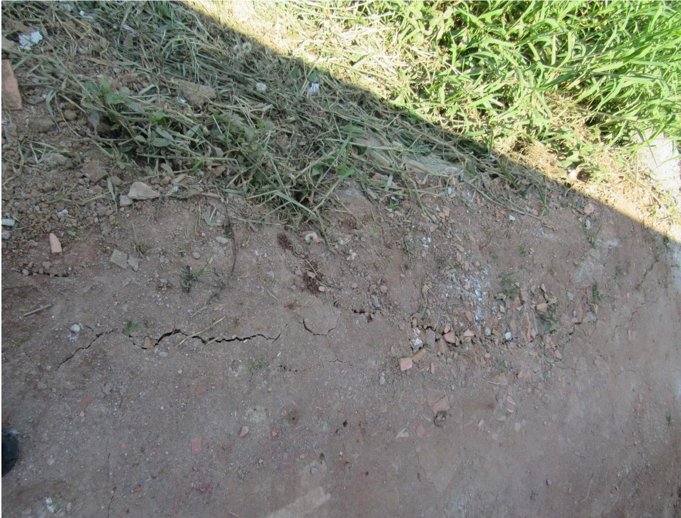
**FC-SBC49\_S3-03** – Tricas no terreno, possivelmente provenientes de aterro mal compactado.
