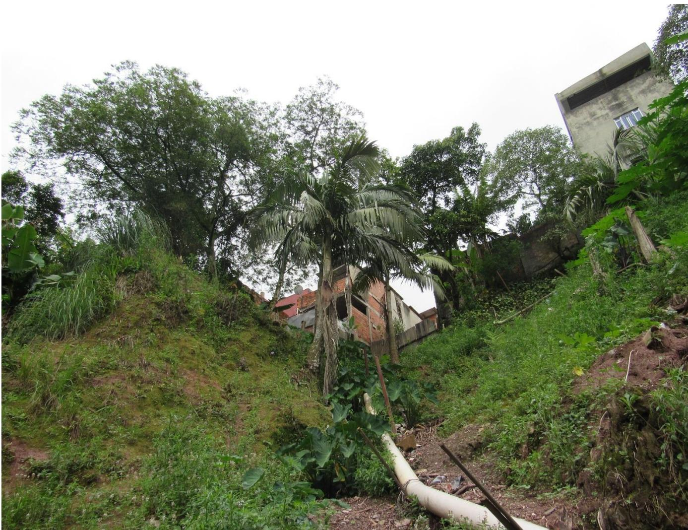
**FC-SBC48\_S3-02** – Destaque encosta no final da Rua Nossa Senhora Aparecida. No centro da imagem um cano (estrutura precária de drenagem) que segundo os moradores concentra águas pluviais e servidas das moradias da crista.
