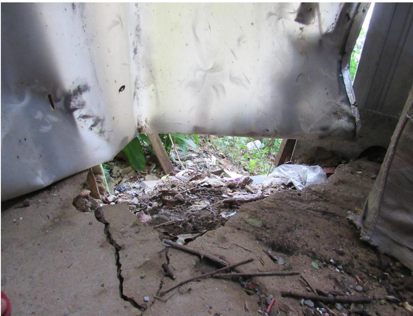
**FC-SBC51\_S1-04** – Sinais de movimentação em do aterro de uma das moradias indicadas para remoção.
