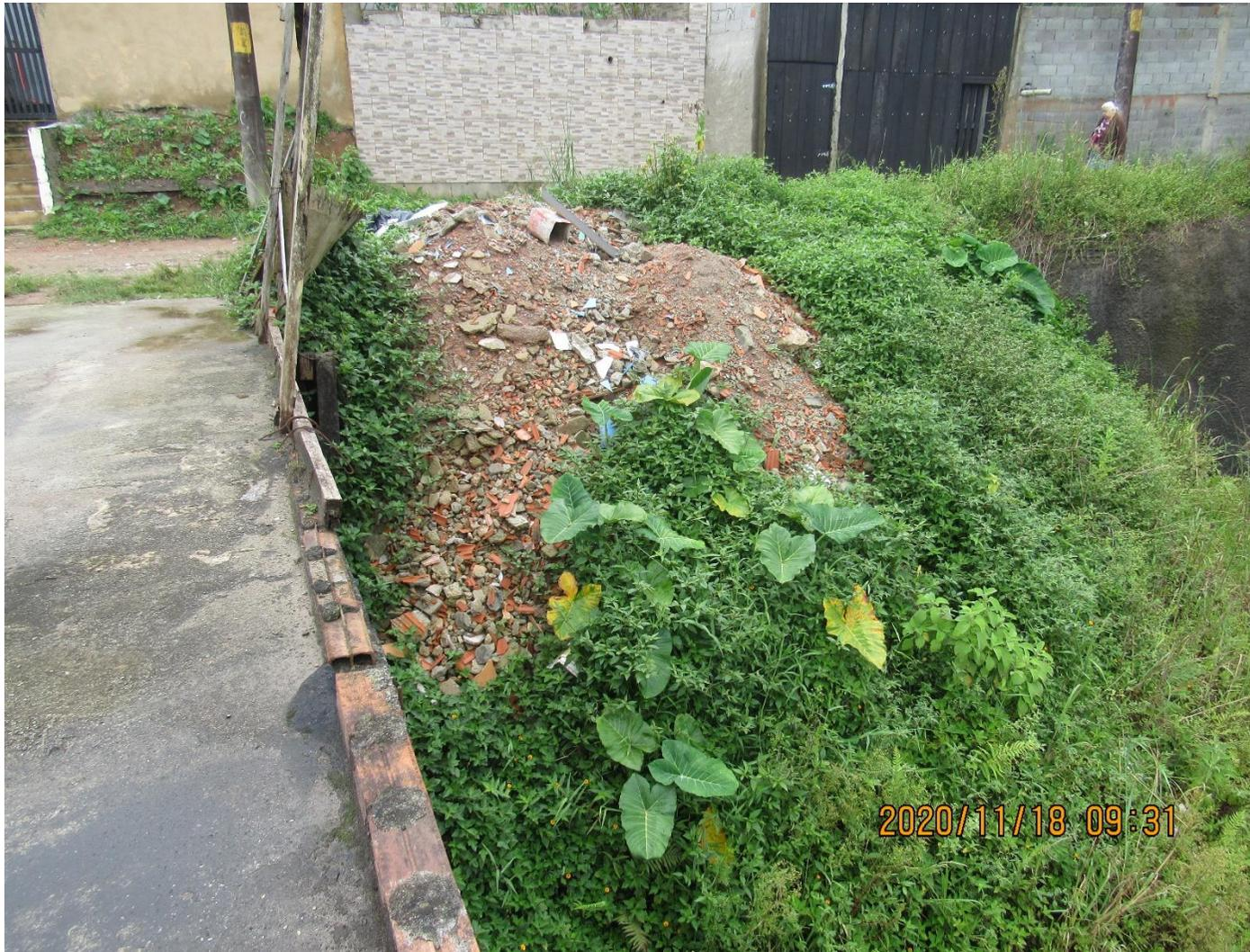
**FC-SBC53\_S1-03** – Material depositado (entulho) na crista da encosta.
