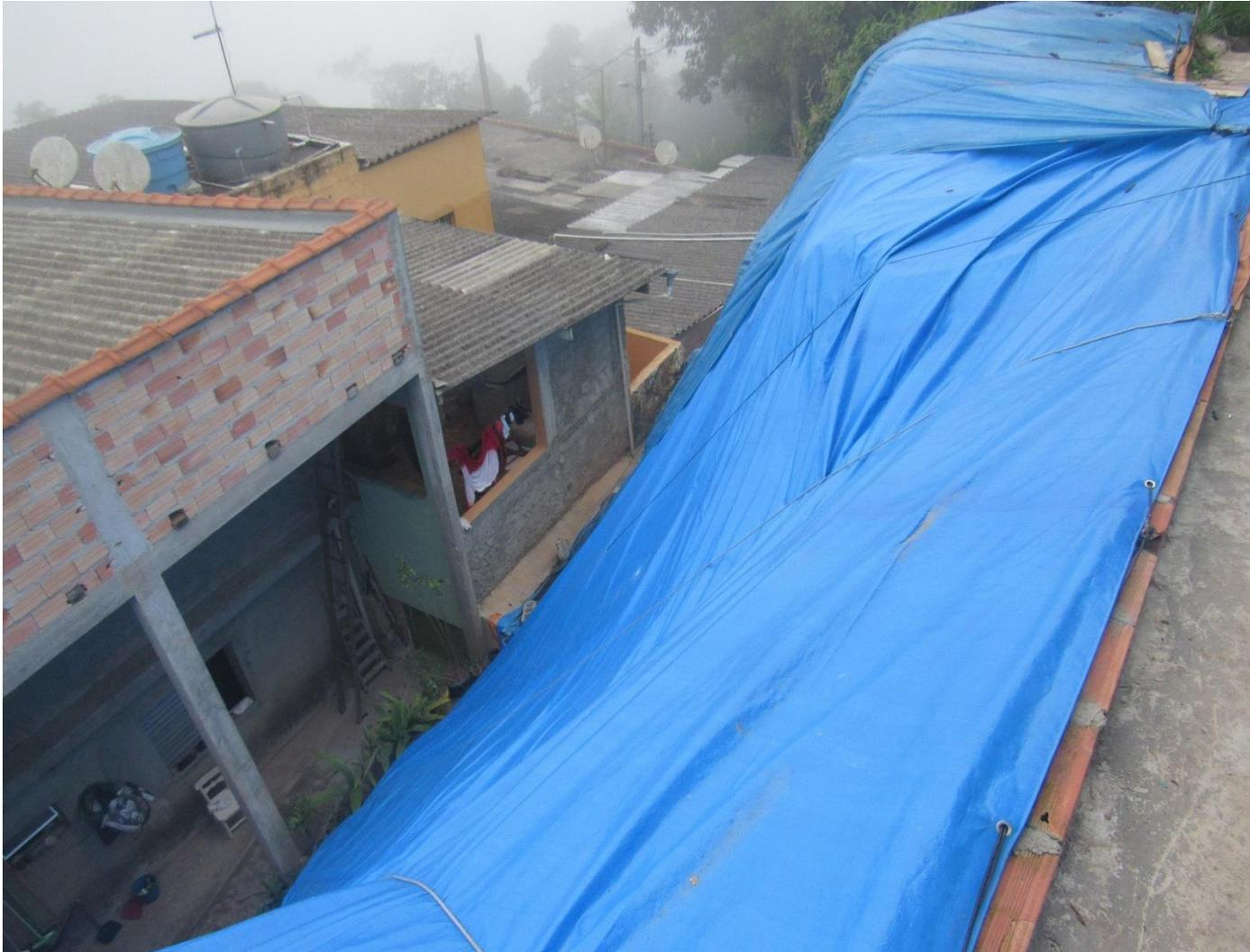
**FC-SBC47\_S1-02** – Destaque para lona colocada em local que ocorreu deslizamento. Os moradores relatam que o processo ocorreu devido ao rompimento de um cano da Sabesp.
