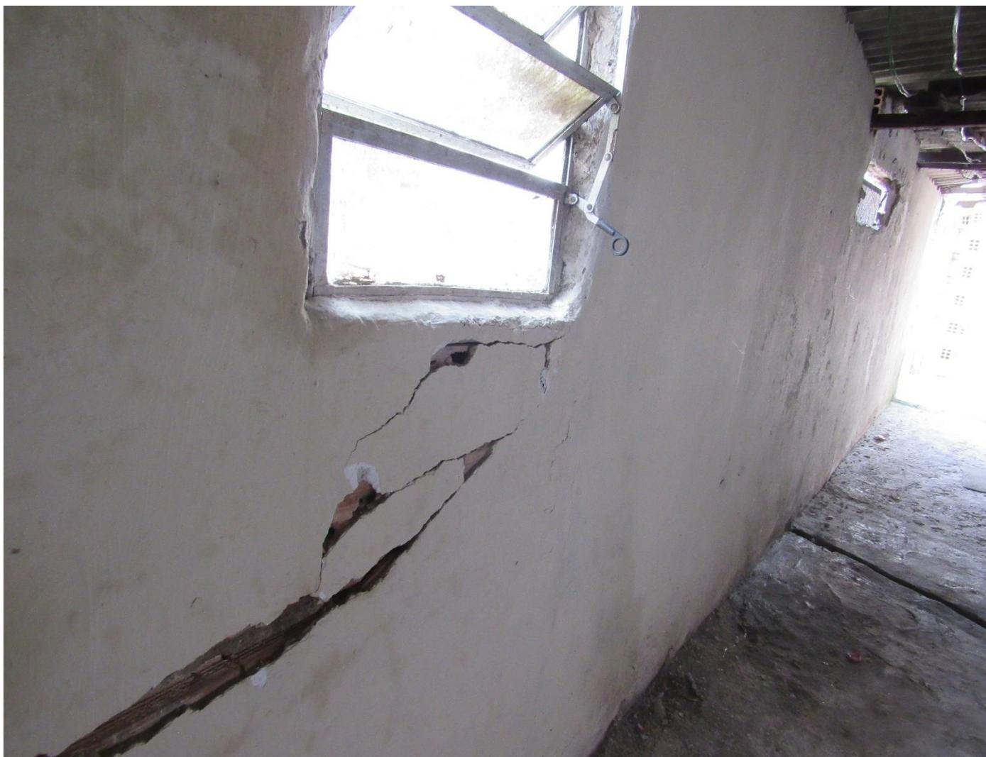
**FC-SBC48\_S11-03** – Trincas na parede de um corredor que dá acesso a várias moradias lindeiras ao córrego.
