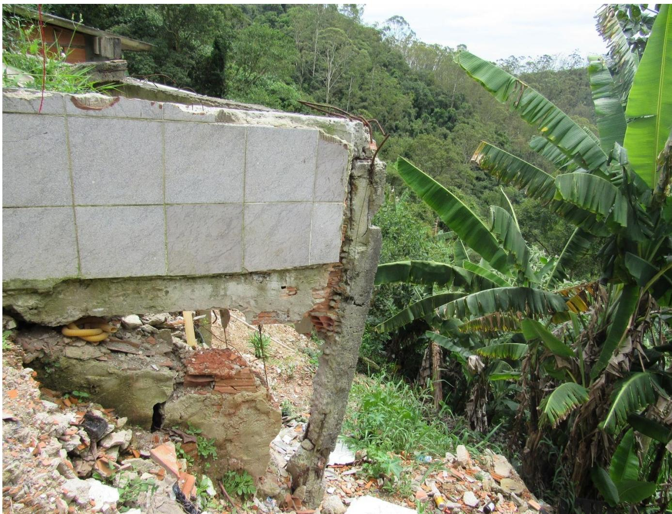
**FC-SBC47\_S8-02** – Destaque para moradia que demolida e o material lançado na encosta.
