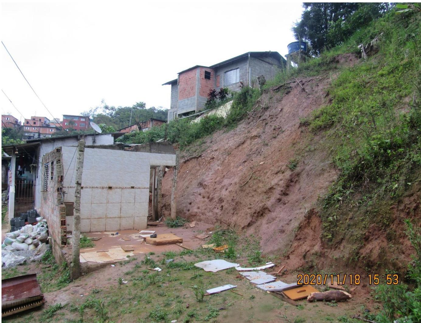
**FC-SBC54\_S3-02** – Destaque para o corte feito no limite esquerdo inferior do setor. A moradia da base parece ter sido demolida.
