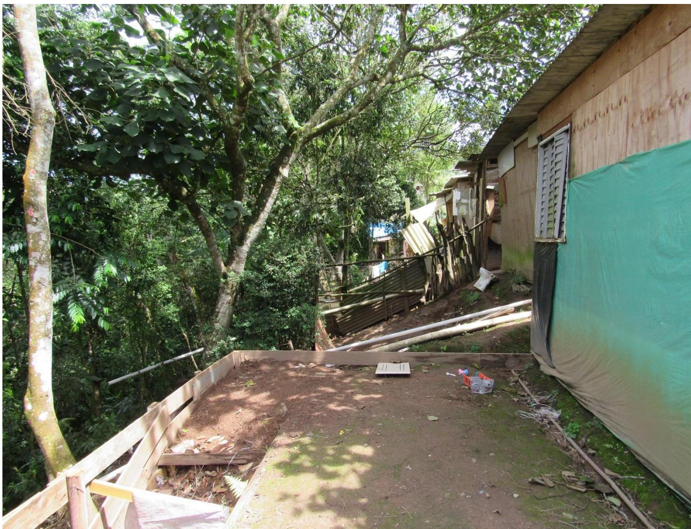
**FC-SBC47\_S5-02** – Destaque para os fundos e a condição dos aterros a jusante das moradias e o lançamento de água servida na meia encosta.
