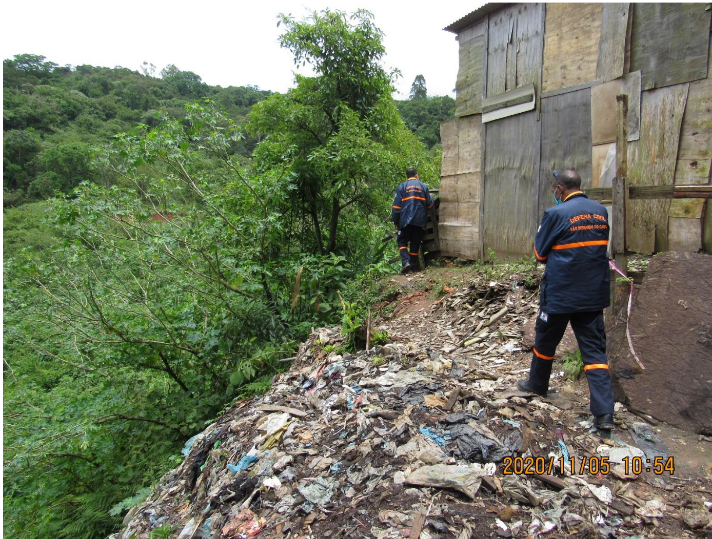
FC-SBC35_S4-01 – Local de descarte inadequado de resíduos, que aparentemente já colapsou. De forma preventiva orientou-se a remoção da moradia que aparece na foto (canto direito do setor).
