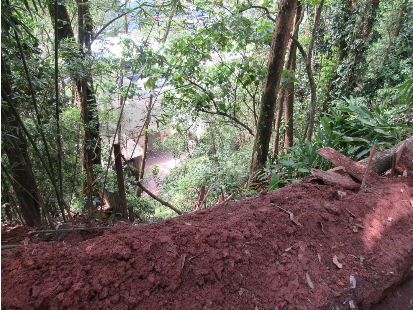
FC-SBC21_S1-03 – Destaque para cicatriz de deslizamento e material depositado (solo) na crista da encosta.
