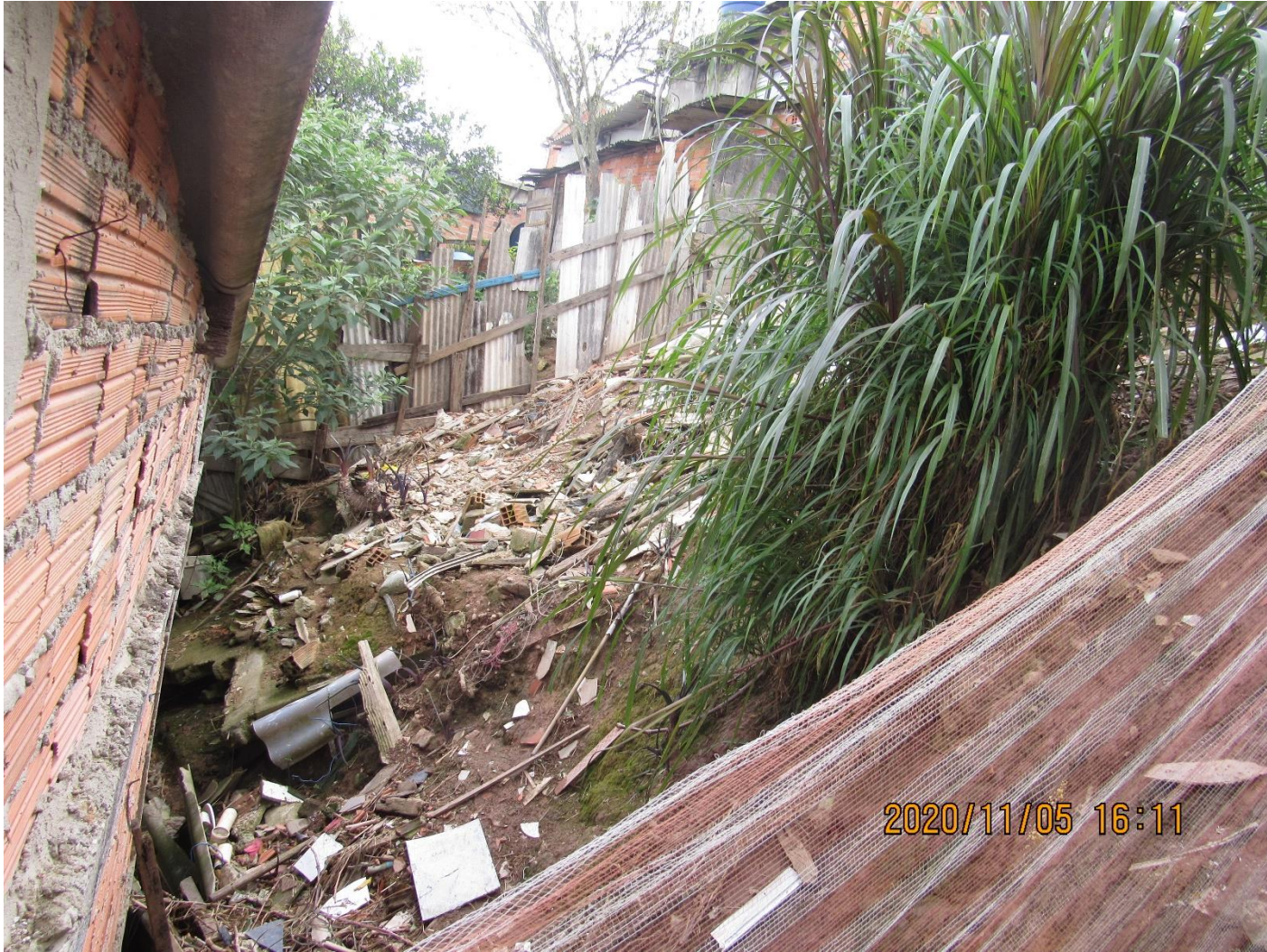
FC-SBC45_S1-02 – Destaque para o material lançado (solo, lixo e entulho) atrás da moradia e a proximidade do talude.
