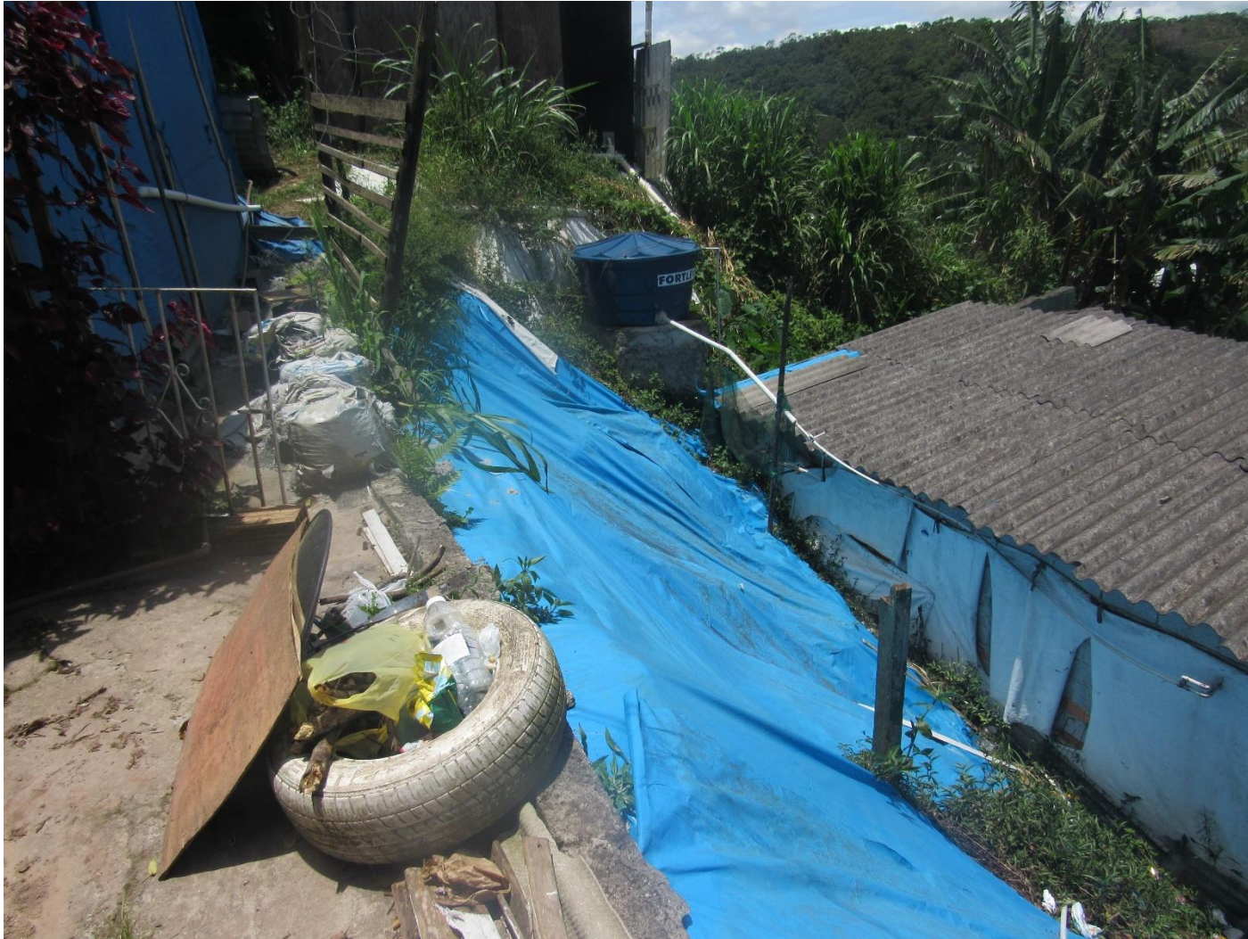
FC-SBC23_S7-03 – Destaque para outro ponto onde ocorreu um possível processo de deslizamento.
