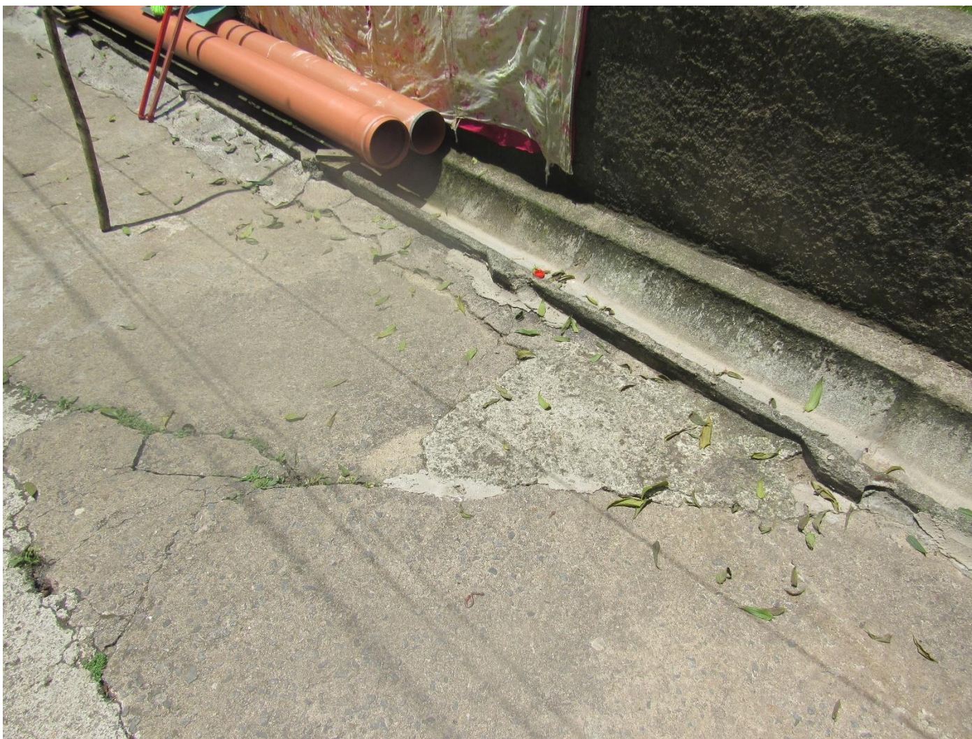
FC-SBC23_S9-02 – Destaque para canaleta na crista do setor.
