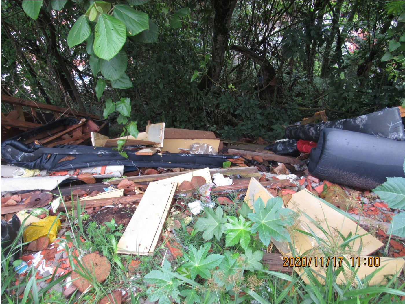
FC-SBC36_S2-03 – Descarte inadequado de material na crista da encosta (Rua Araponga).
