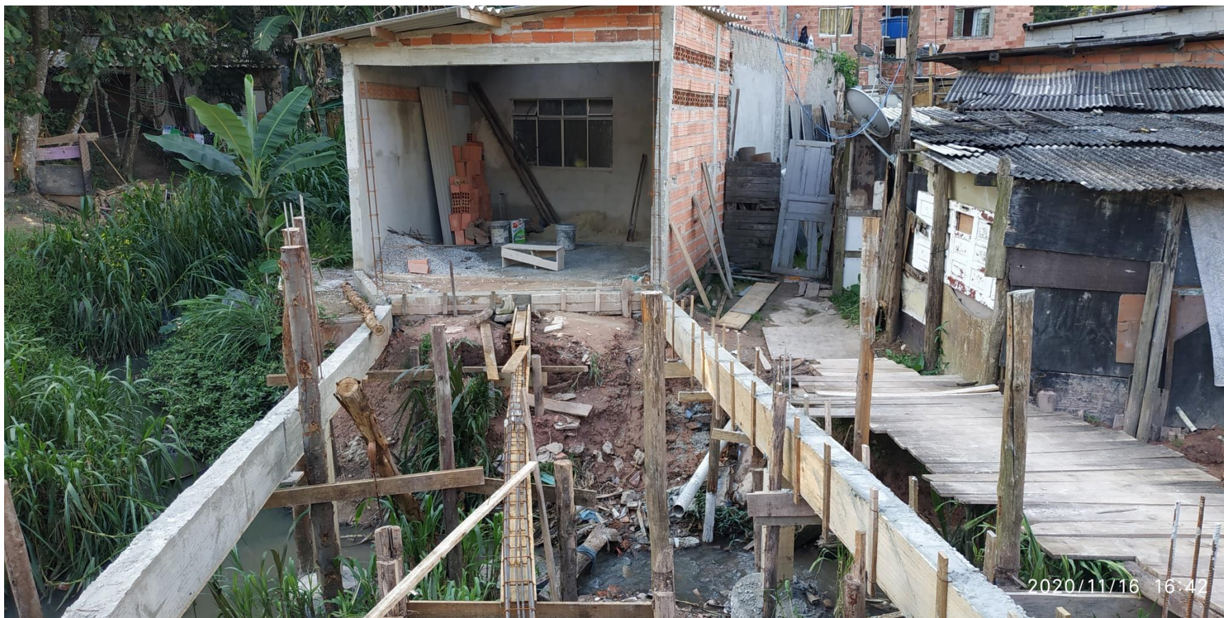
FC-SBC34_S4-03 – Moradias sendo construídas no local de encontro dos dois córregos que fazem parte do setor.
