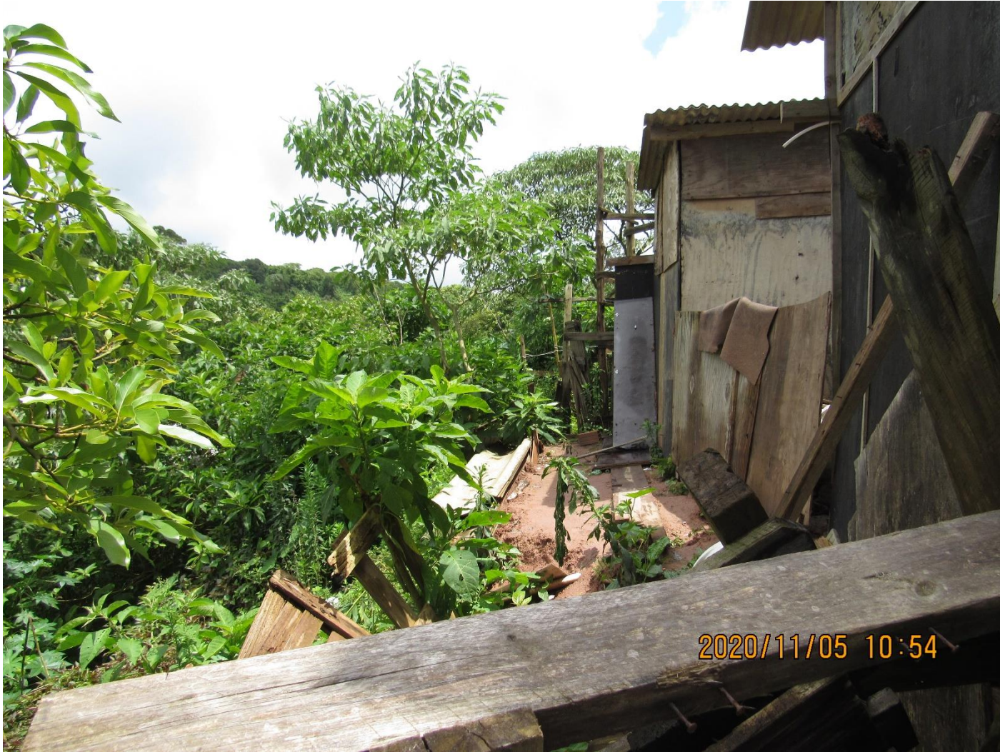
FC-SBC35_S4-02 – Destaque para proximidade das moradias à crista da encosta e para precariedade das moradias.
