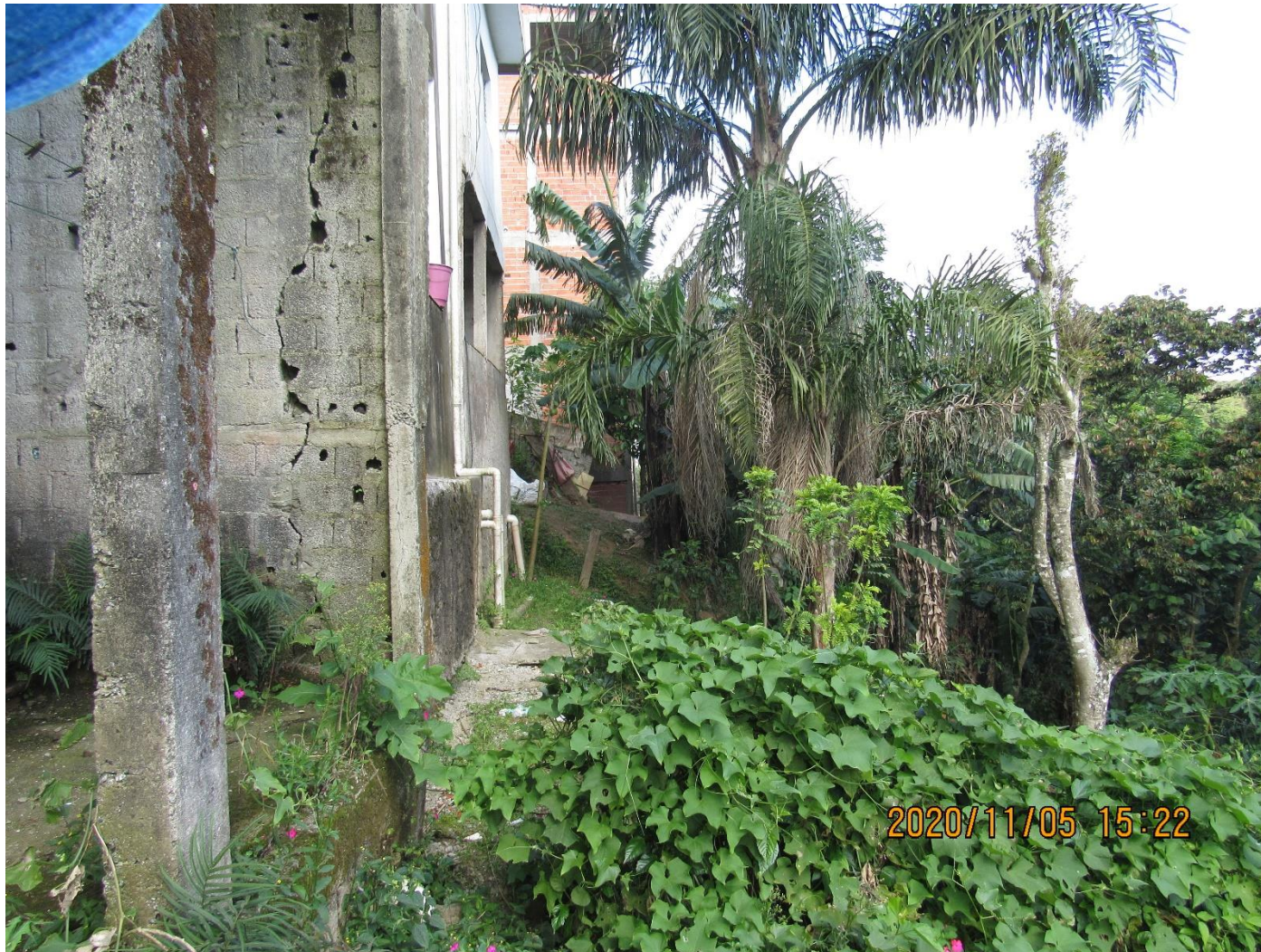
FC-SBC45_S2-01 – Faixa a jusante das moradias à meia encosta.
