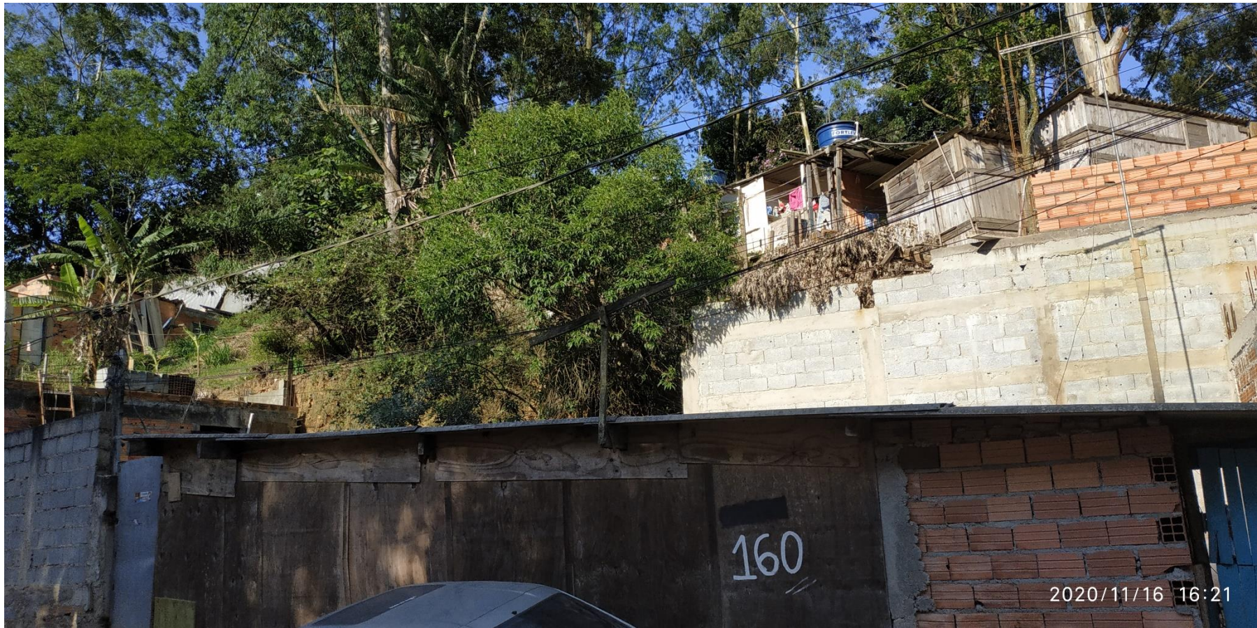
FC-SBC34_S2-01 – Vista para a encosta e as primeiras moradias do lado direito do setor.
