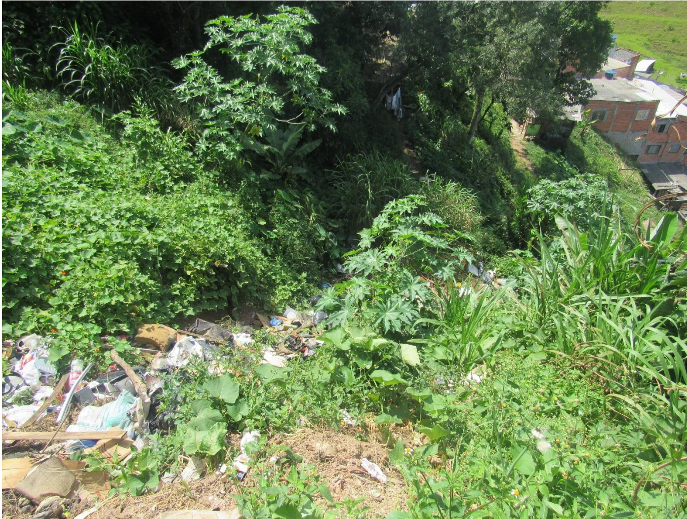
FC-SBC23_S6-02 – Destaque para descarte irregular de material na encosta. Na parte superior da foto é possível observar duas moradias de madeira, uma delas encoberta pela vegetação, indicadas para remoção.
