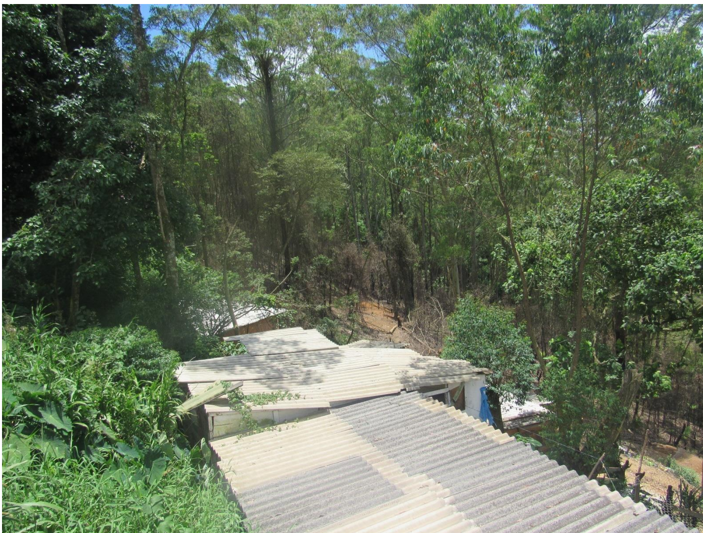
FC-SBC23_S8-02 – Destaque para o limite direito do setor. O local está sendo ocupado por moradias precárias.
