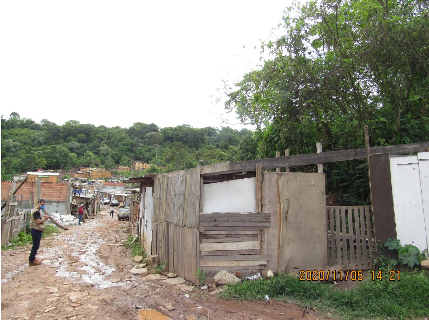
FC-SBC35_S3-02 – Vista da faixa de casas do setor, detalhe para condição precária do viário.
