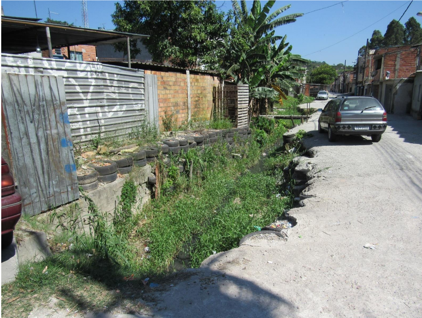
FC-SBC39_S1-03 – Limite do setor com a Estrada dos Alvarengas, destaque para contenção das margens feitas com pneus.
