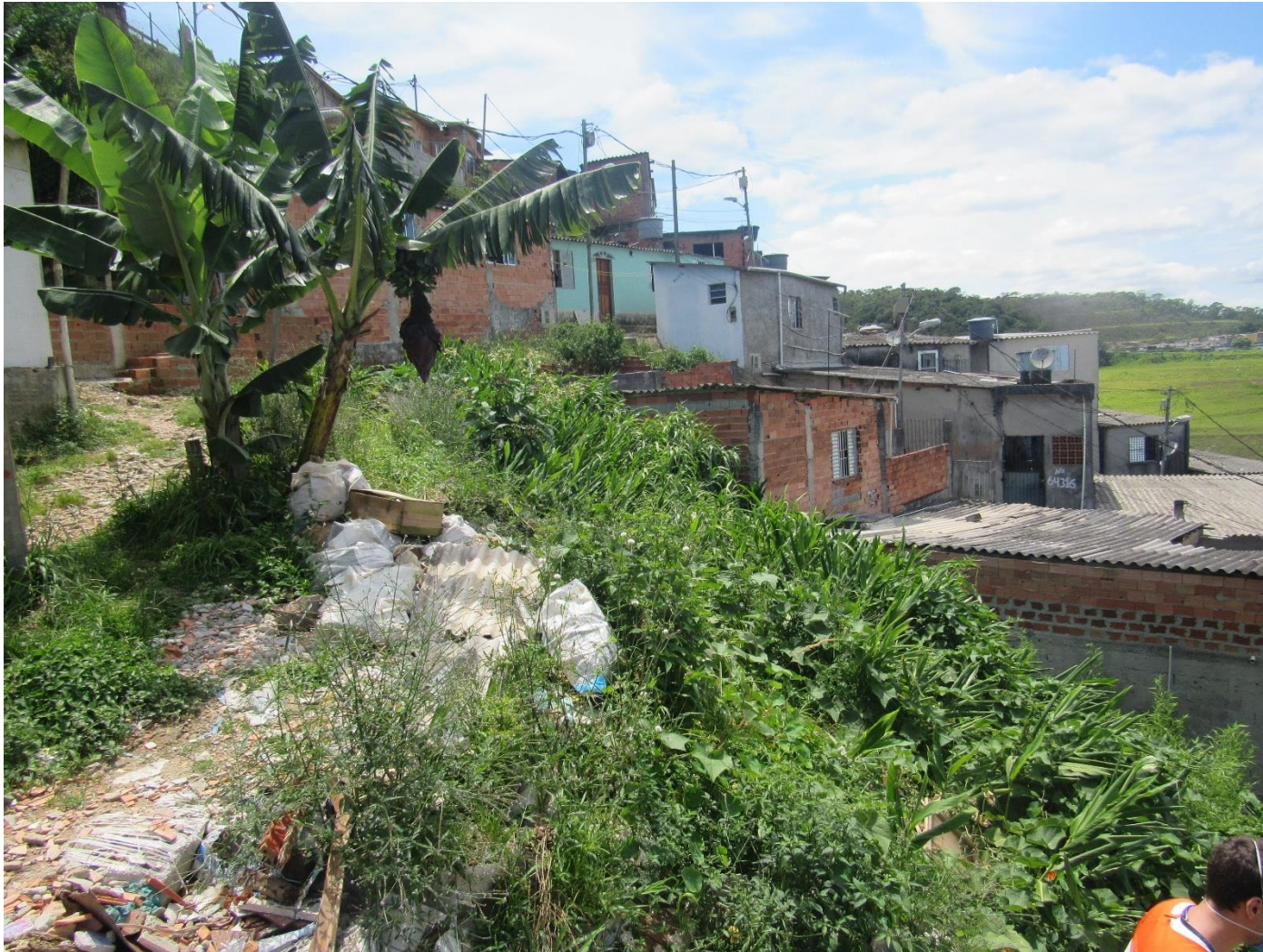
FC-SBC23_S5-01 – Destaque para descarte irregular de material na crista da encosta.
