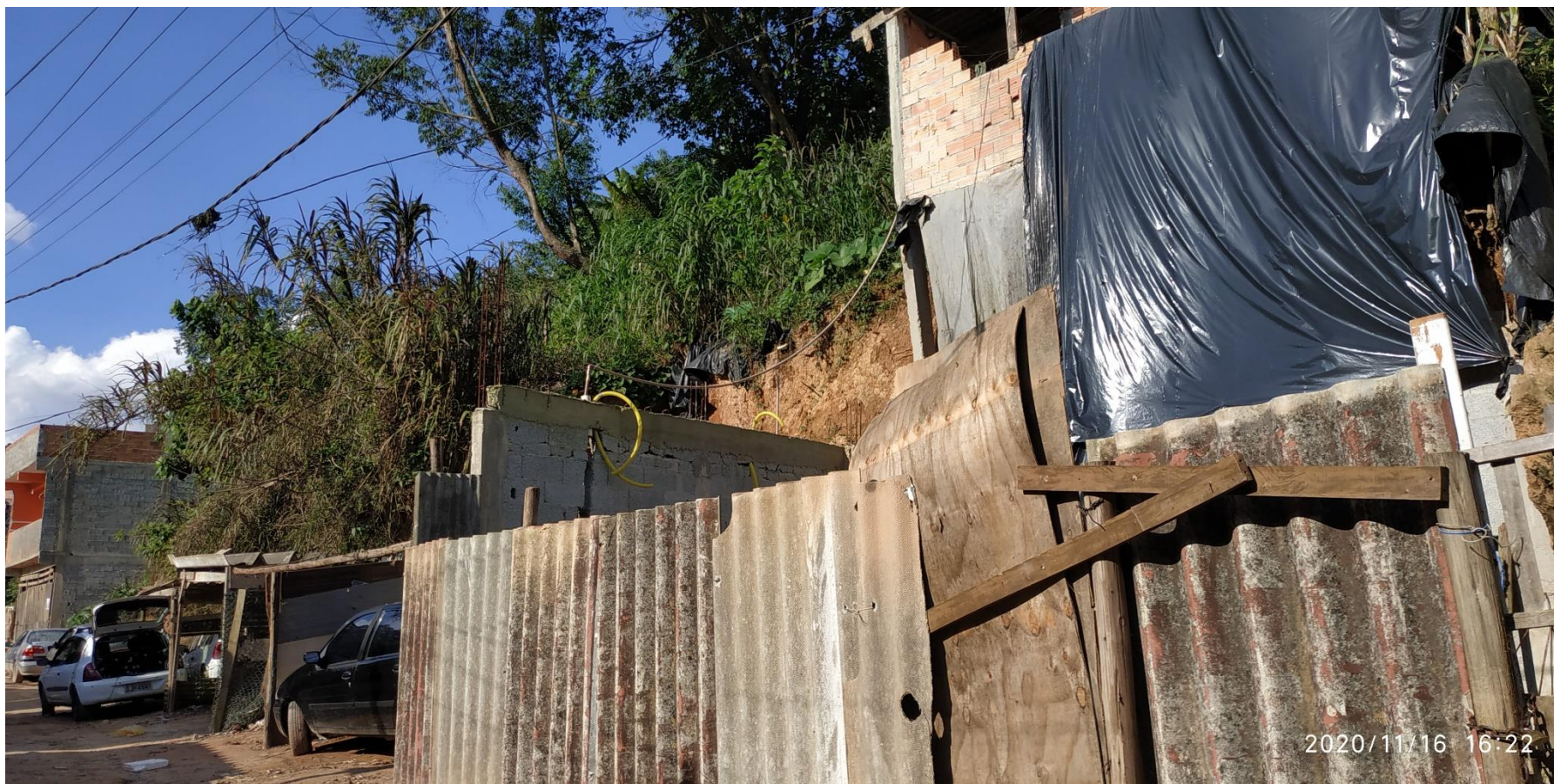
FC-SBC34_S2-02 – Destaque para os cortes feitos na encosta para instalação das casas no sopé.
