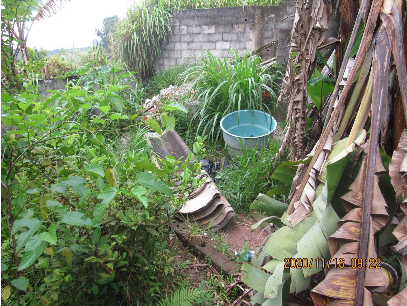
FC-SBC45_S5-02 – Material depositado a montante do corte identificado na foto FC-SBC45_S5-01.
