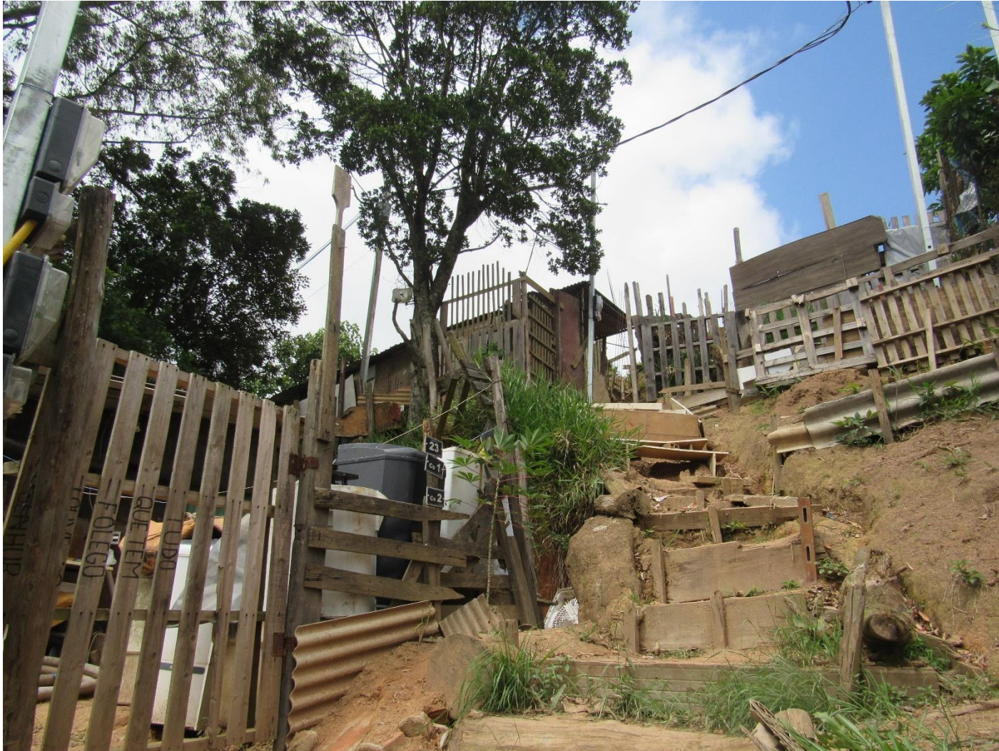
FC-SBC44_S1-02 – Precariedade das moradias e da escadaria próxima à crista da encosta.
