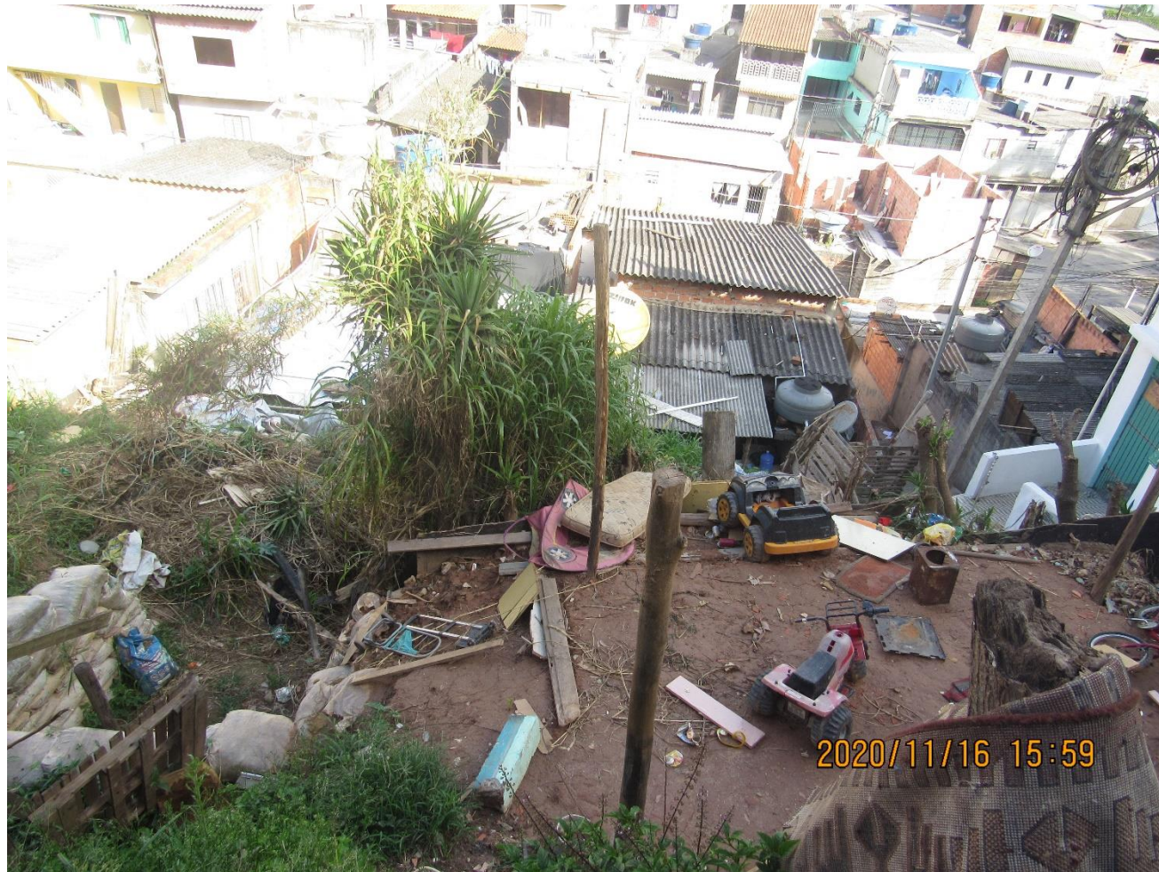
FC-SBC34_S1-01 – Vista do aterro a jusante da moradia no canto superior esquerdo do setor.
