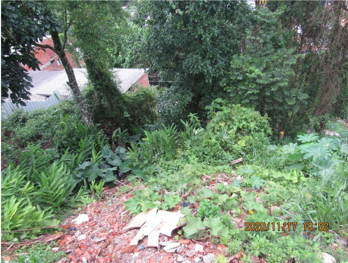
FC-SBC36_S1-02 – Descarte inadequado de material na crista da encosta. Final da Rua Kiwi.
