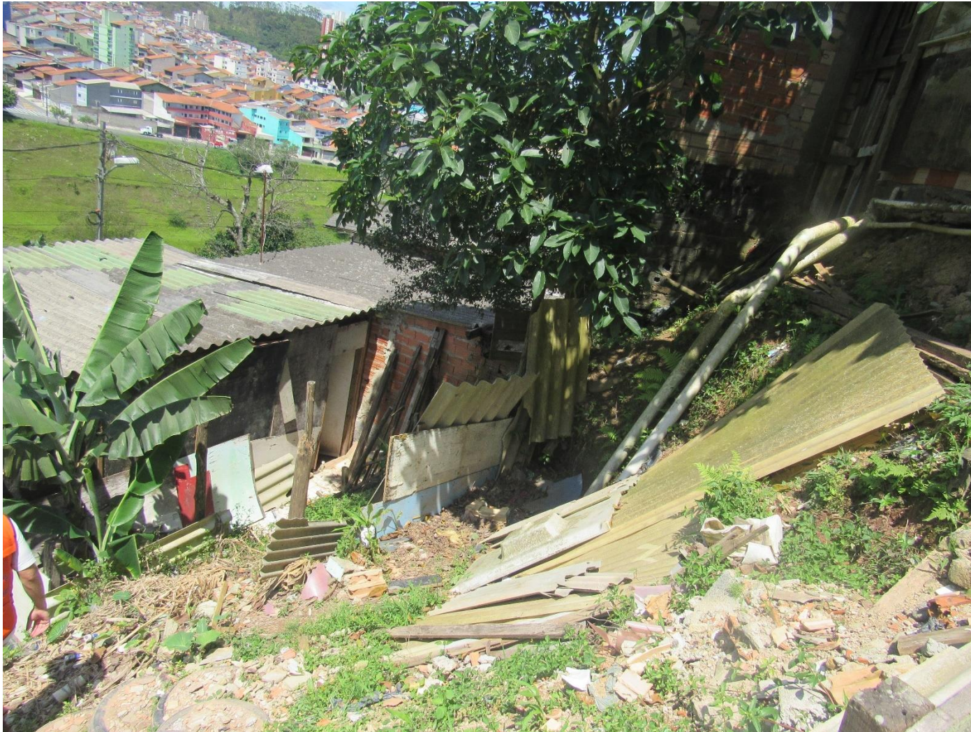
FC-SBC23_S4-01 – Destaque para descarte irregular de material no limite esquerdo do setor.
