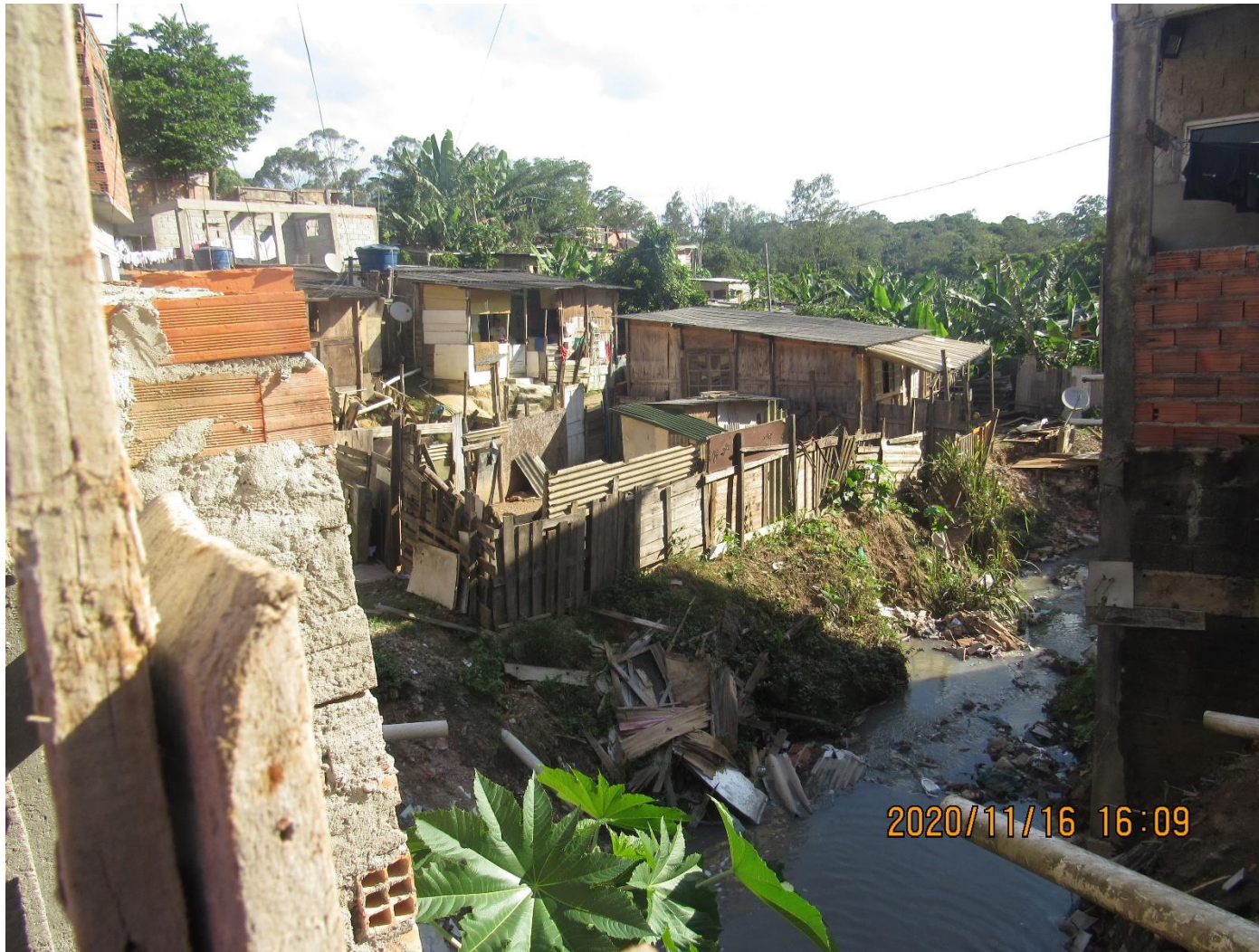
FC-SBC34_S3-01 – Situação das moradias em uma das extremidades do setor no final da Avenida 1001.
