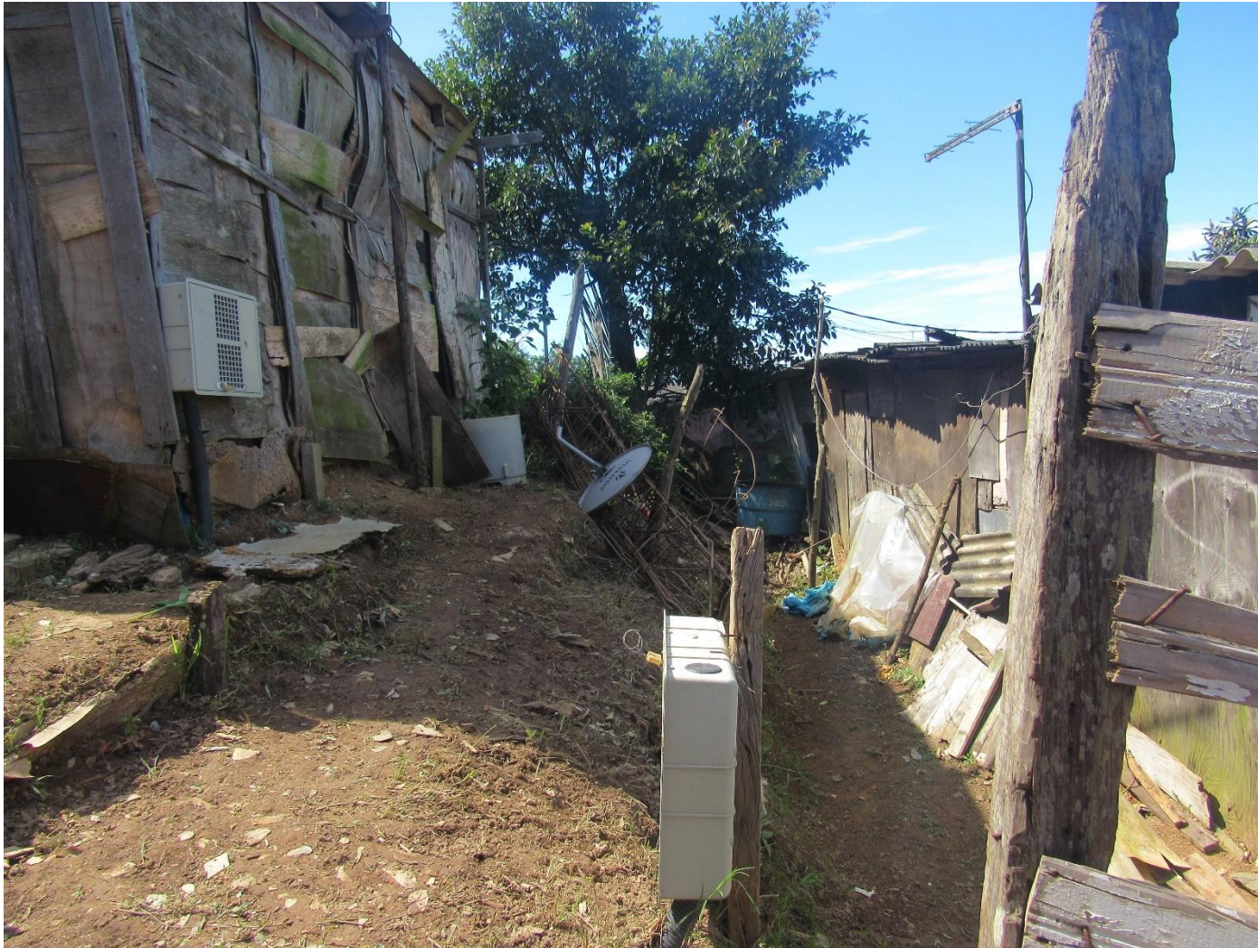
FC-SBC23_S2-01 – Destaque para precariedade das construções.
