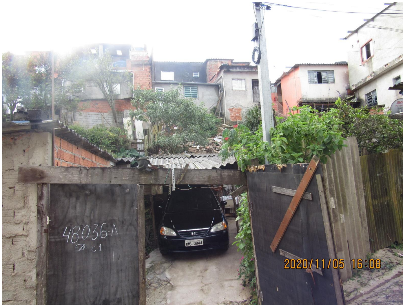
FC-SBC45_S1-01 – Vista para moradia do setor. É possível observar o material lançado no talude atrás da edificação.
