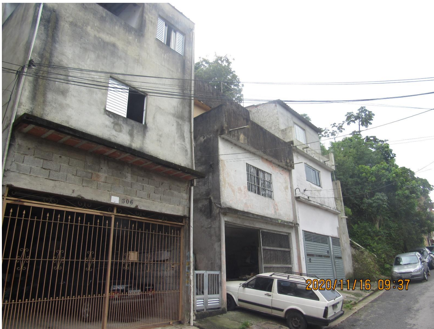
FC-SBC45_S4-02 – Vista para as duas moradias no sopé da encosta que integram o setor (a moradia 306 não faz parte do setor).
