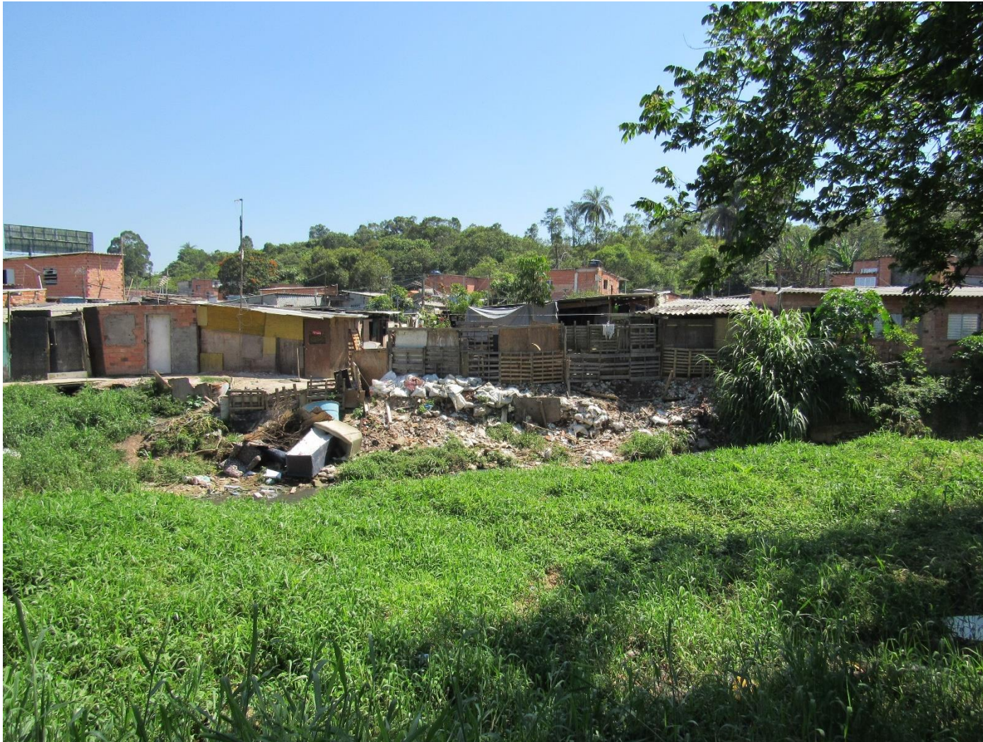
FC-SBC40_S1-01 – Destaque para local de descarte irregular de resíduos (lixo e entulho).
