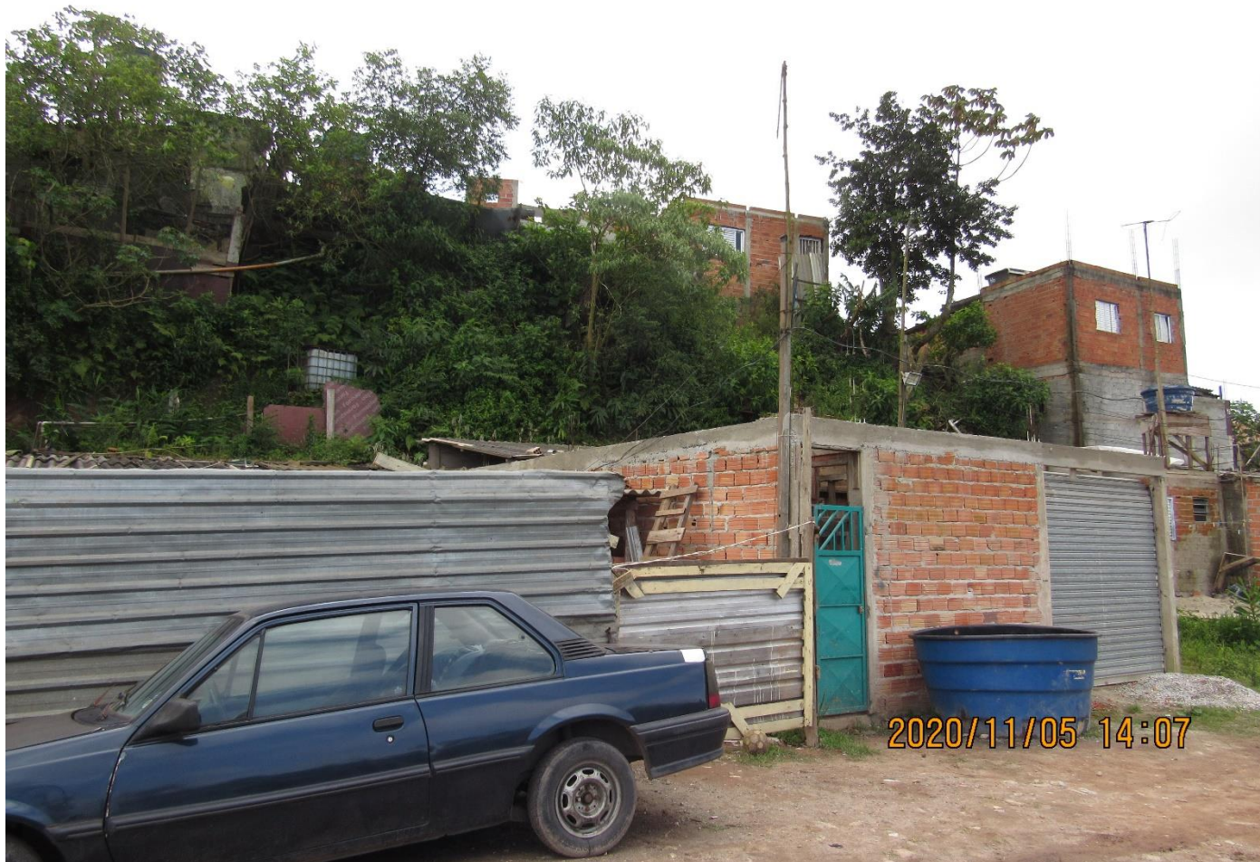
FC-SBC35_S1-01 – Vista do canto direito do setor, destaque para amplitude da encosta vegetada e a proximidade das moradias à crista e ao sopé.
