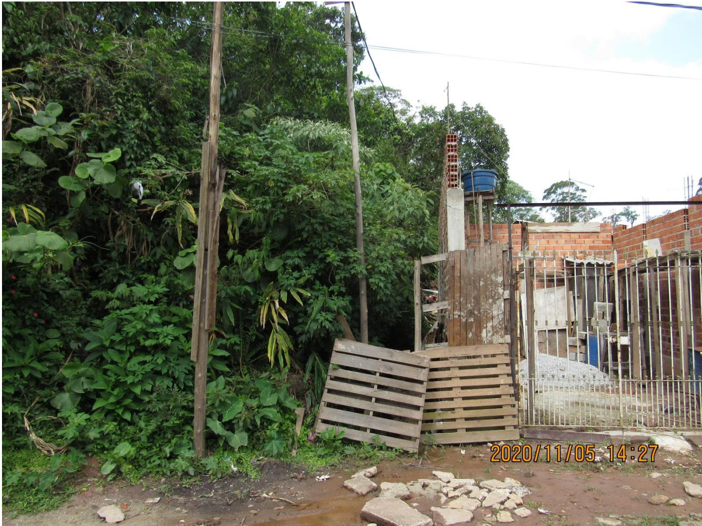
FC-SBC35_S2-02 – Destaque para proximidade da moradia do sopé à encosta.
