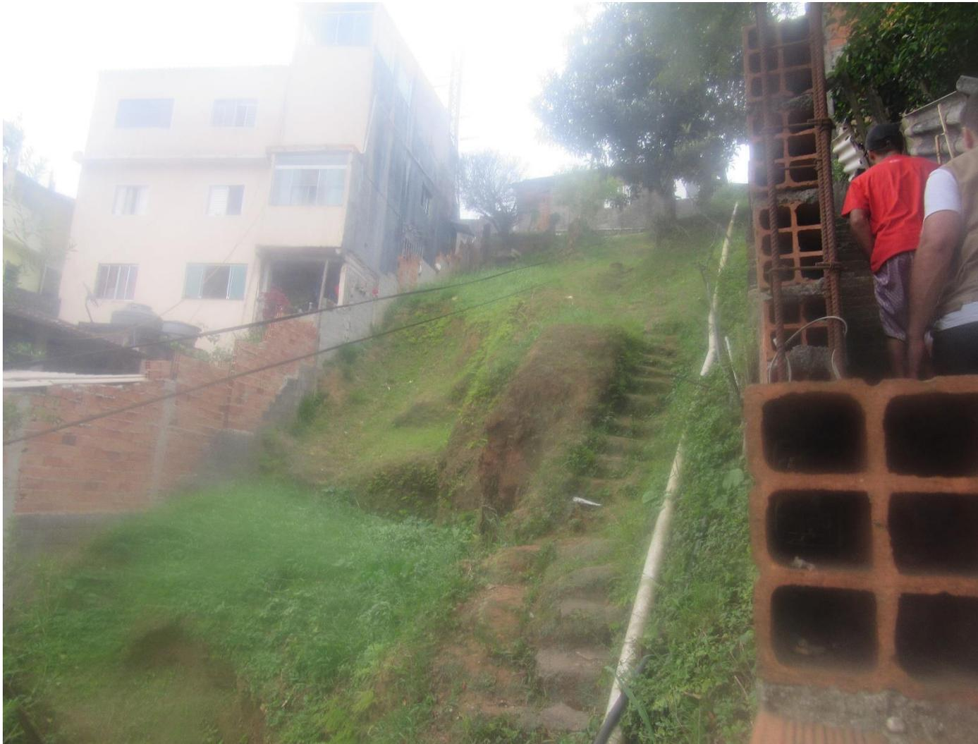
**FC-SBC18\_S1-02** – Destaque para os degraus de abatimento no terreno do limite esquerdo do setor.
