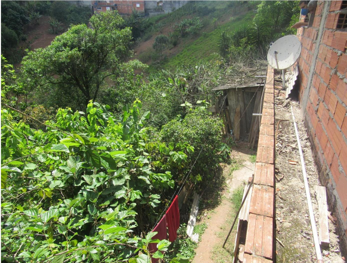
**FC-SBC03\_S3-01** – Vista para área a jusante da edificação localizada na parte superior do setor. Registrado na foto o momento em que a equipe do LabGRis indica ao morador a necessidade de afastar a água proveniente dos telhados da crista do talude logo a jusante da edificação.
