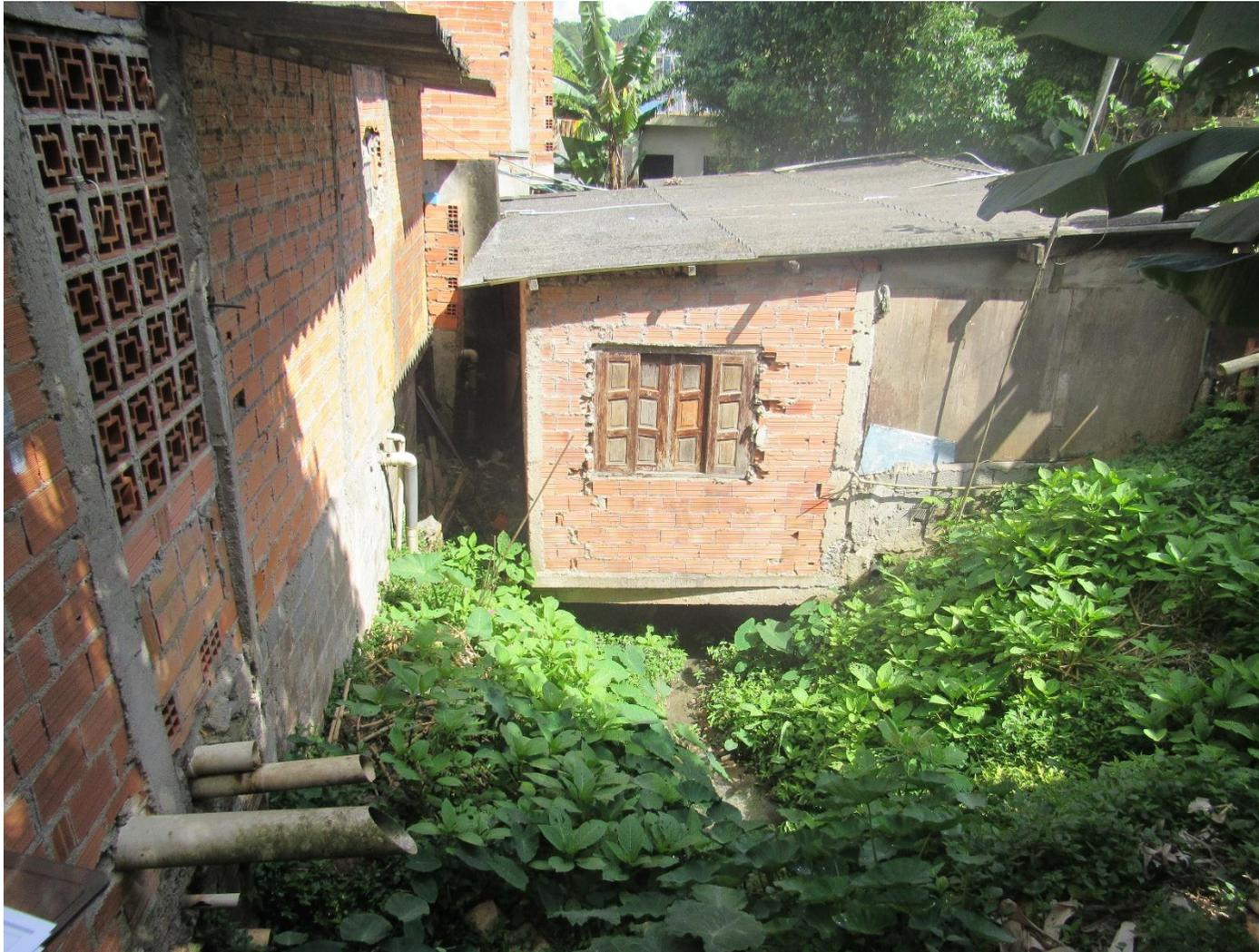
**FC-SBC07\_S1-01** – Casa indicada para remoção localizada sobre o córrego. Detalhe para construção mista, possivelmente deixando de ser madeira para se tornar de alvenaria.
