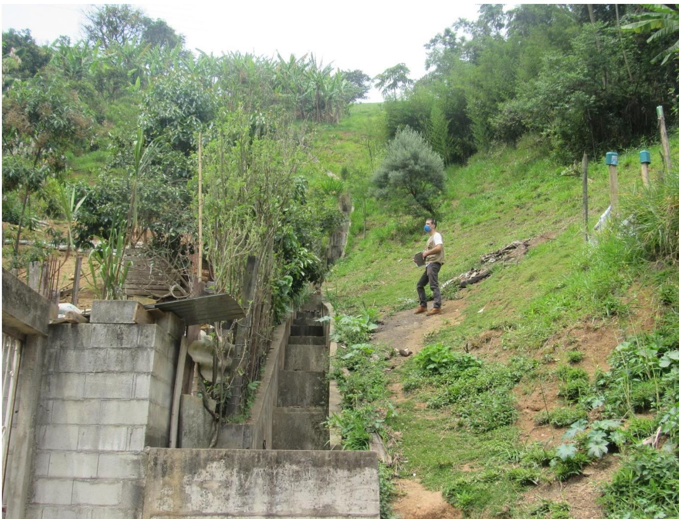
**FC-SBC14\_S1-03** – Destaque para escada hidráulica ligada a uma canaleta de meia encosta instalada como medida de prevenção após a ocorrência de deslizamentos no local.
