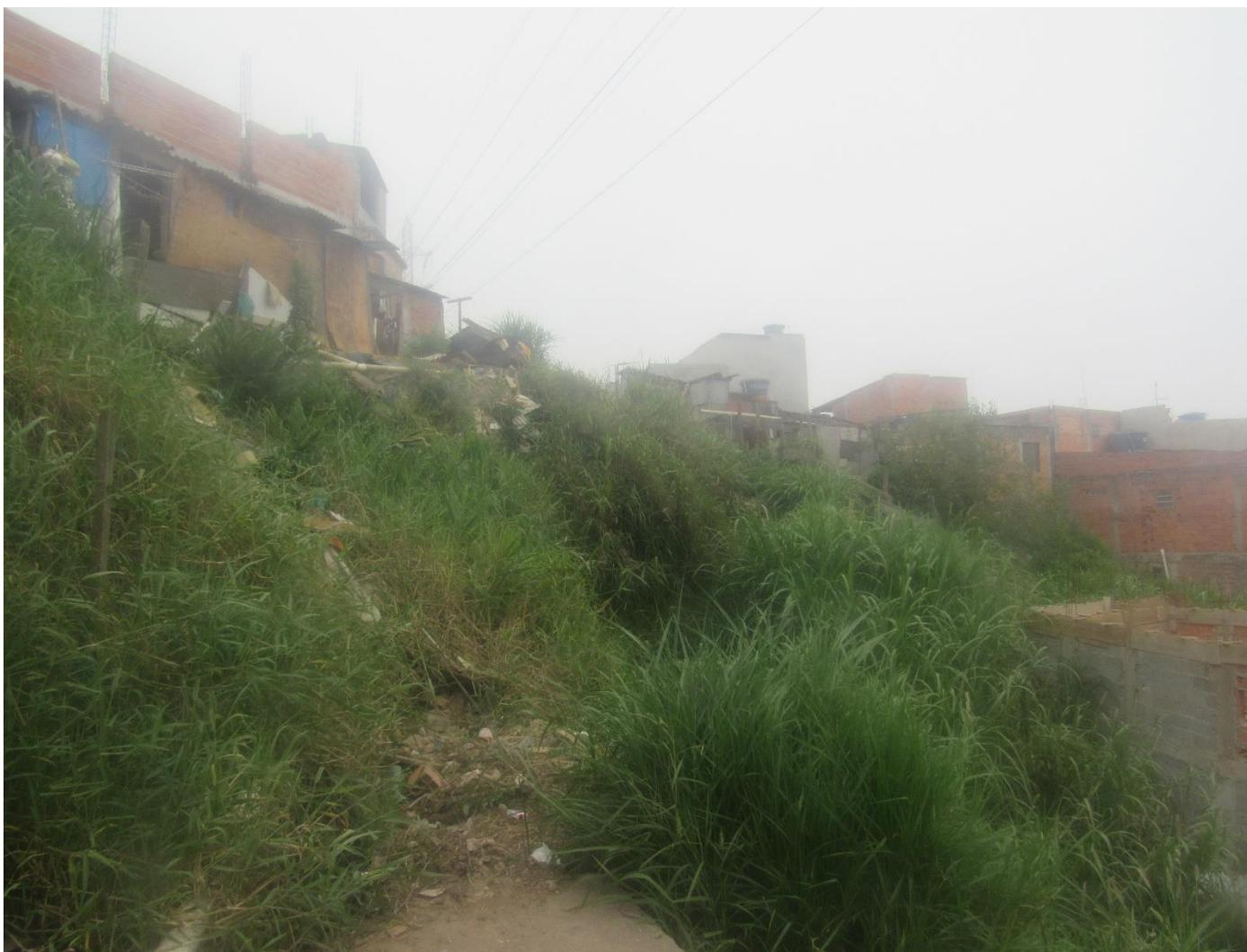
**FC-SBC18\_S3-02** – Destaque para o material depositado a jusante da moradia (indicada para remoção) e possível cicatriz de deslizamento no centro da imagem.
