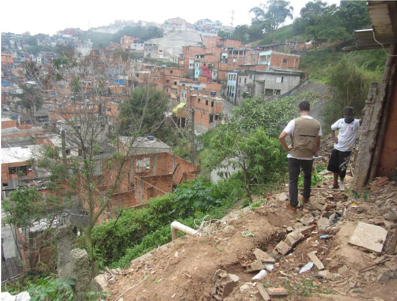
**FC-SBC15\_S2-01** – Orientação ao morador sobre a condição de risco de deslizamento no local. A moradia estava sendo reconstruída sobre os escombros de uma demolição.
