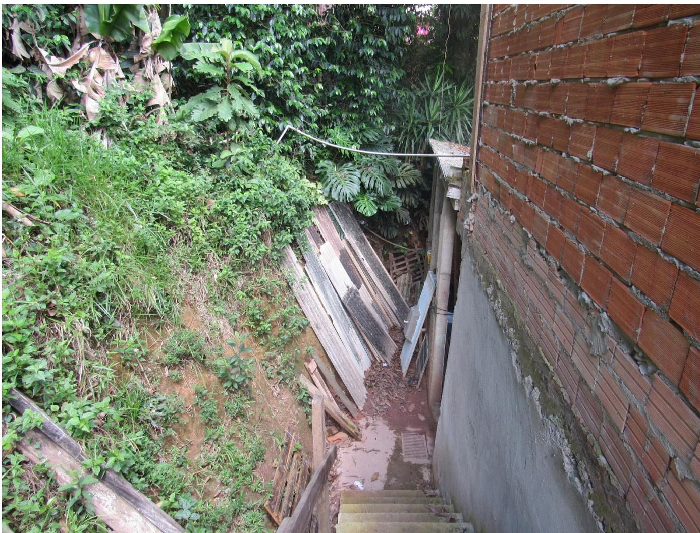
**FC-SBC07\_S3-02** – Fundo da edificação localizada na parte superior do setor. O morador foi orientado a não realizar cortes no talude a montante da edificação e monitorá-lo; e ao perceber qualquer movimentação, contatar a Defesa Civil.
