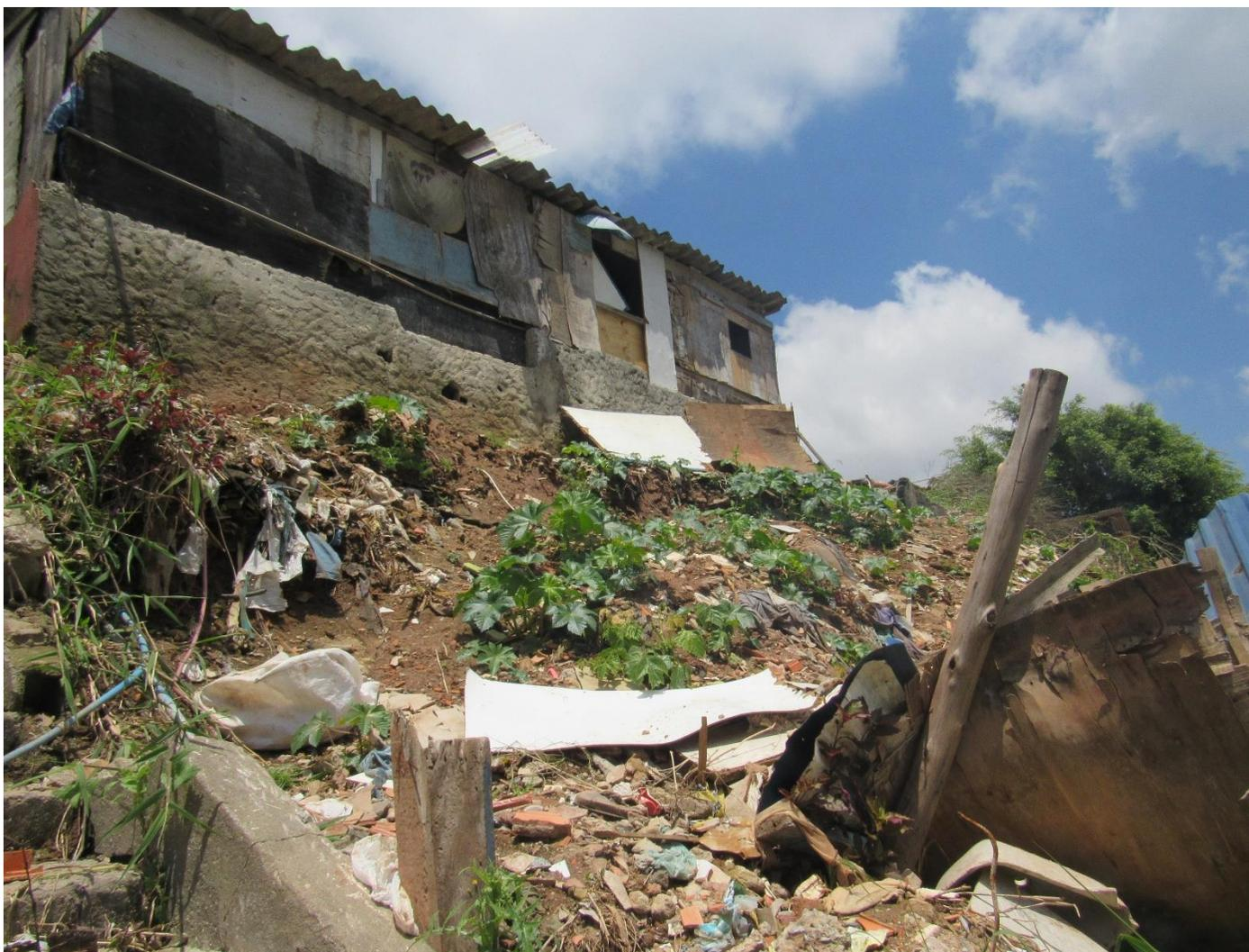
**FC-SBC08\_S4-02** – Casa indicada para remoção e material depositado no talude (lixo, entulho e solo).
