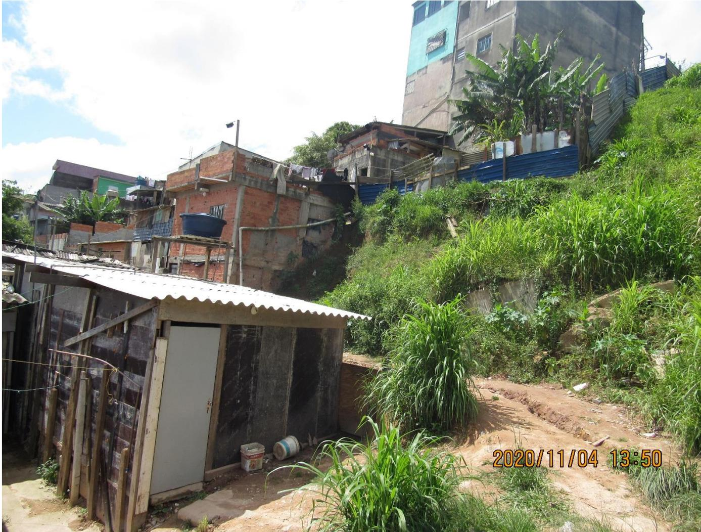
**FC-SBC08\_S2-03** – Destaque para o limite esquerdo setor. A foto demonstra o talude íngreme a montante de uma das casas, entretanto, há uma viela de 3 a 4 metros que os separam.
