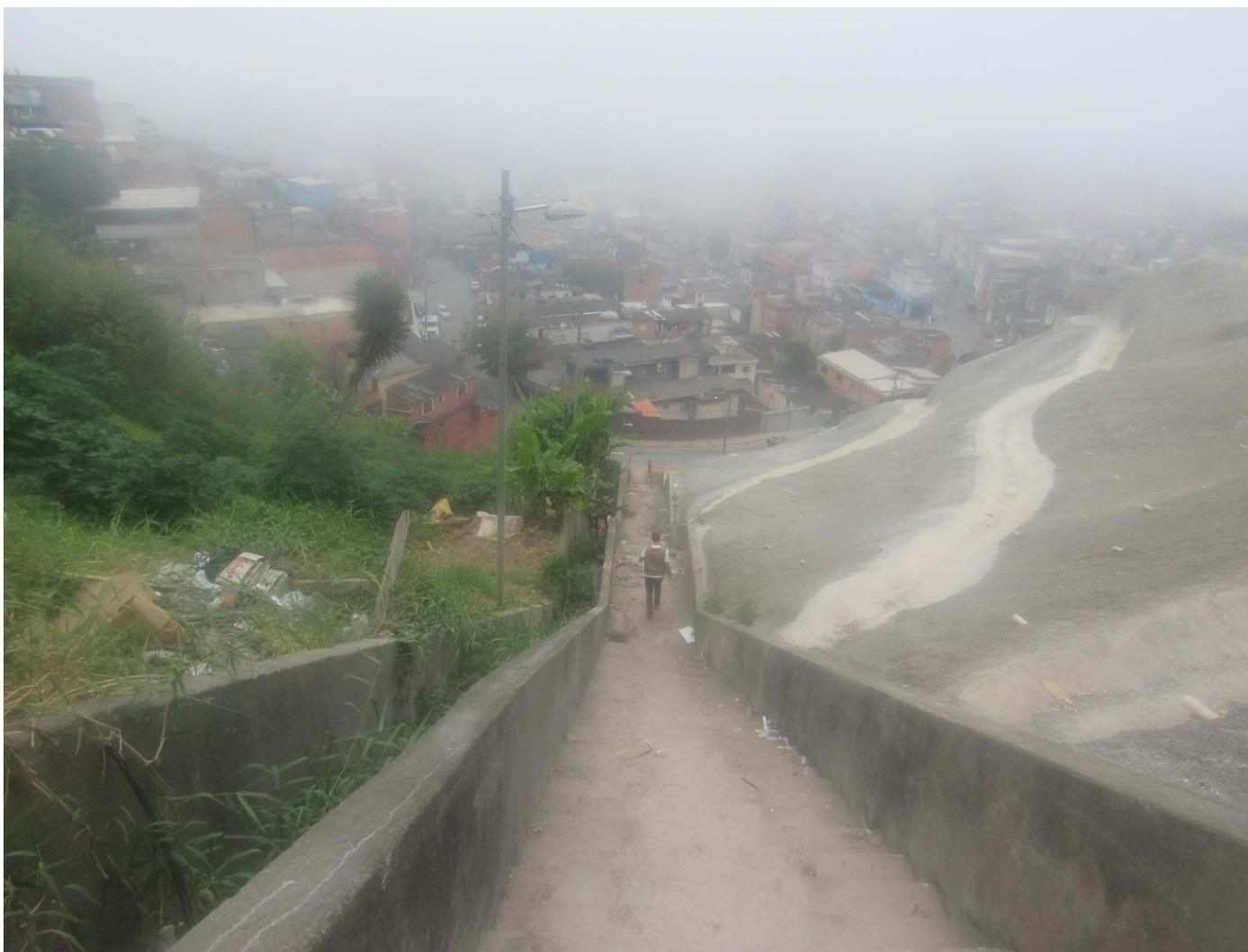
**FC-SBC18\_S2-02** – Destaque para escada hidráulica (necessitando de limpeza) e para obra (concreto projetado) ao lado do setor.
