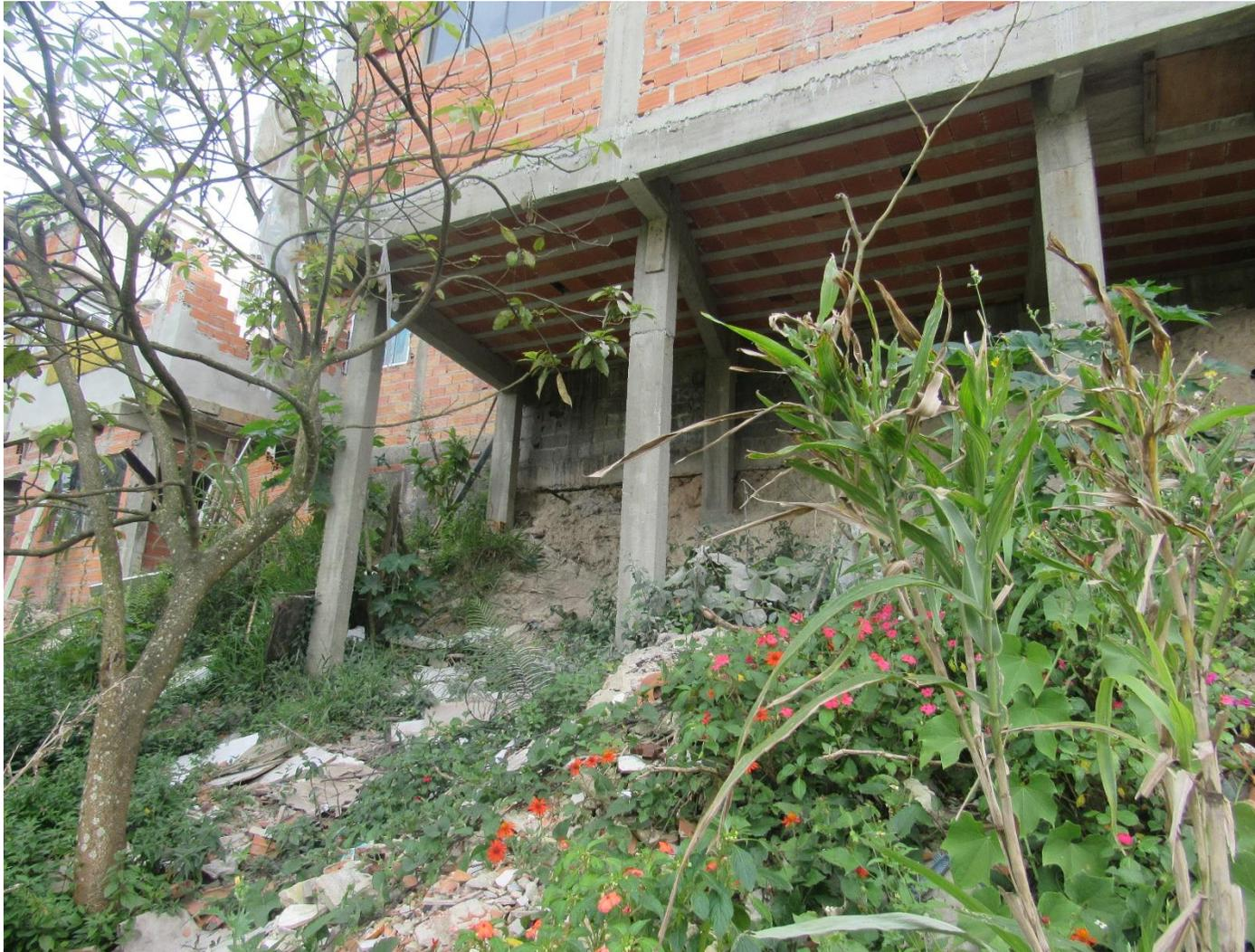
FC-SBC13\_S2-01 – Destaque para casa sobre pilotis e o descarte inadequado de resíduos na encosta (entulho).
