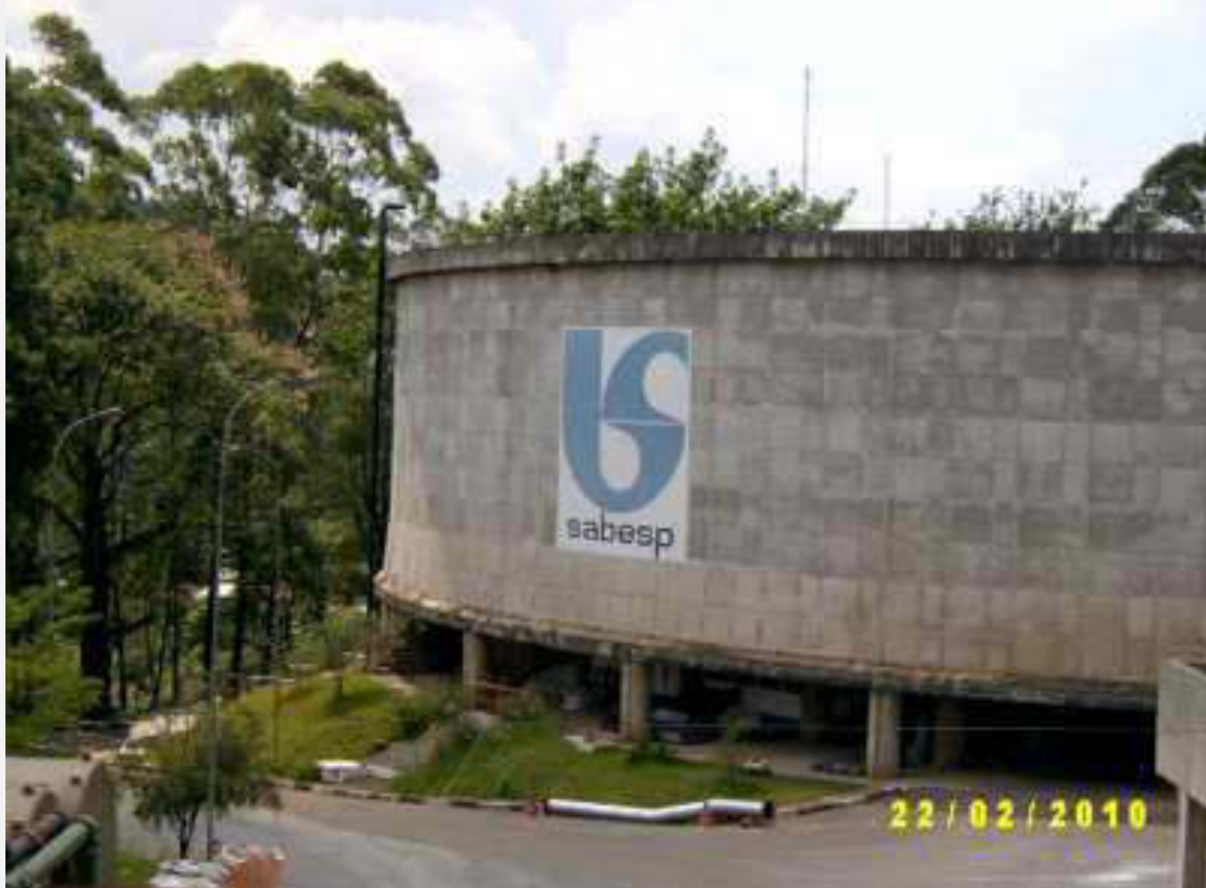
Vista do Reservatório Principal
