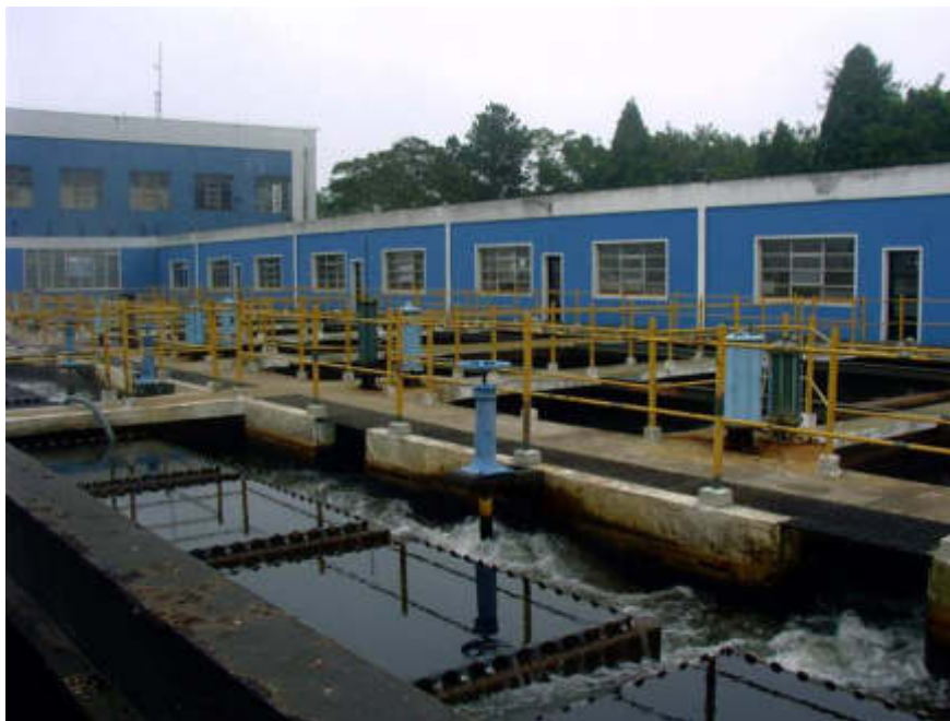
Figura 75 – Outra vista dos filtros pertencentes a “Ala Velha” da ETA Rio Grande
