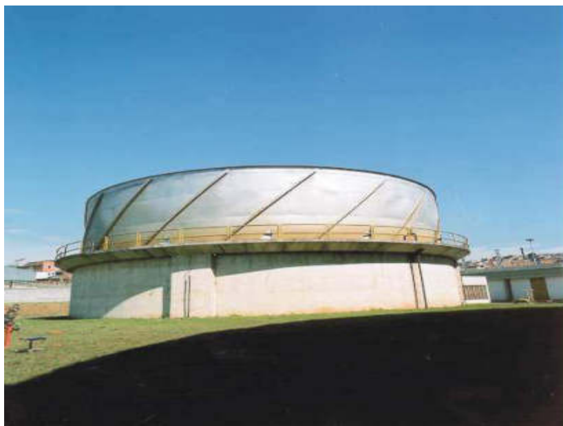
Figura 98 - Vista do gasômetro da ETE ABC
