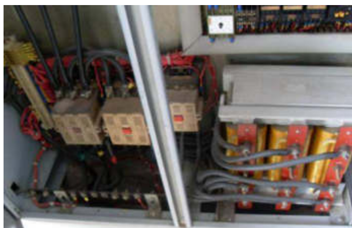
Figura 183 - Acionamento com Chave Compensadora
