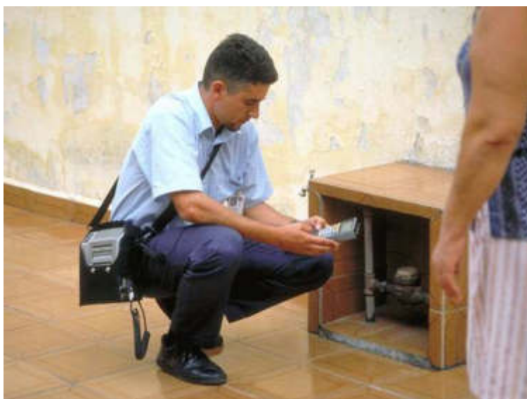
Figura 187 - Leitura do hidrômetro na unidade consumidora
