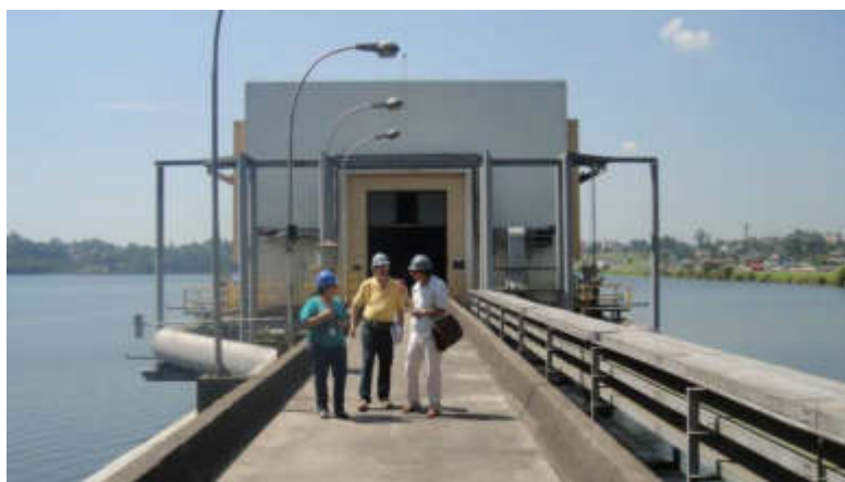
Figura 28 - Vista geral da elevatória de água bruta pertencente a ETA Rio Grande
