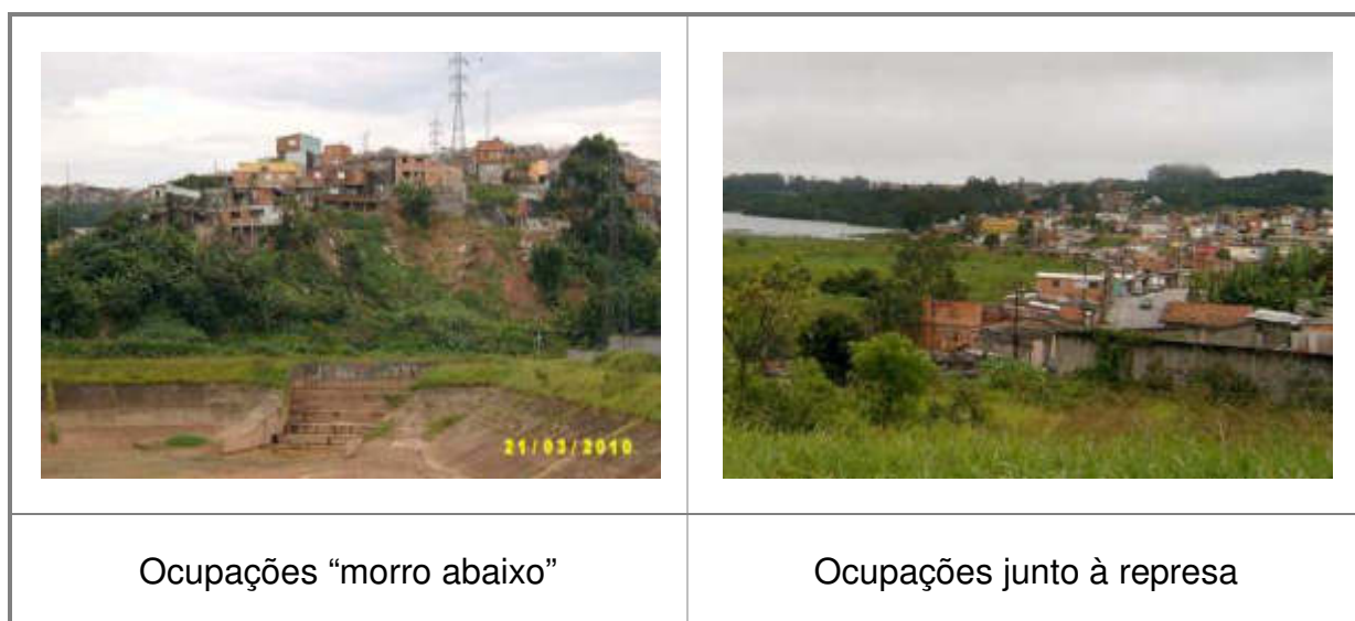
Figura 87 – Duas situações onde é difícil esgotar
