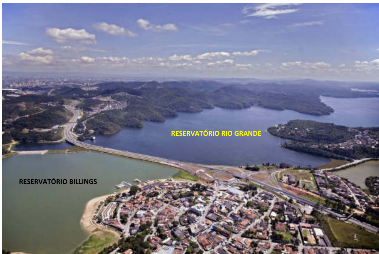
Figura 22 - Vista parcial dos reservatórios Rio Grande e Billings na passagem da Via Anchieta
