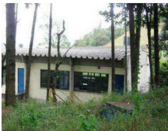
Figura 125 - Edifício do Centro de Controle dos Motores (CCM)
