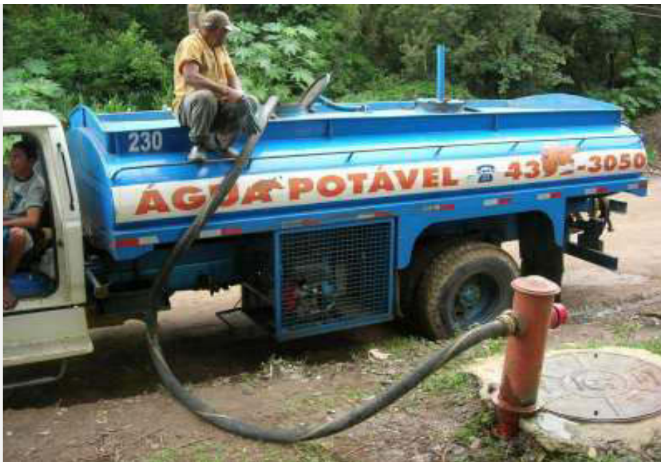
Caminhão pipa sendo abastecido no Bairro Tatetos para atender usuários afastados
