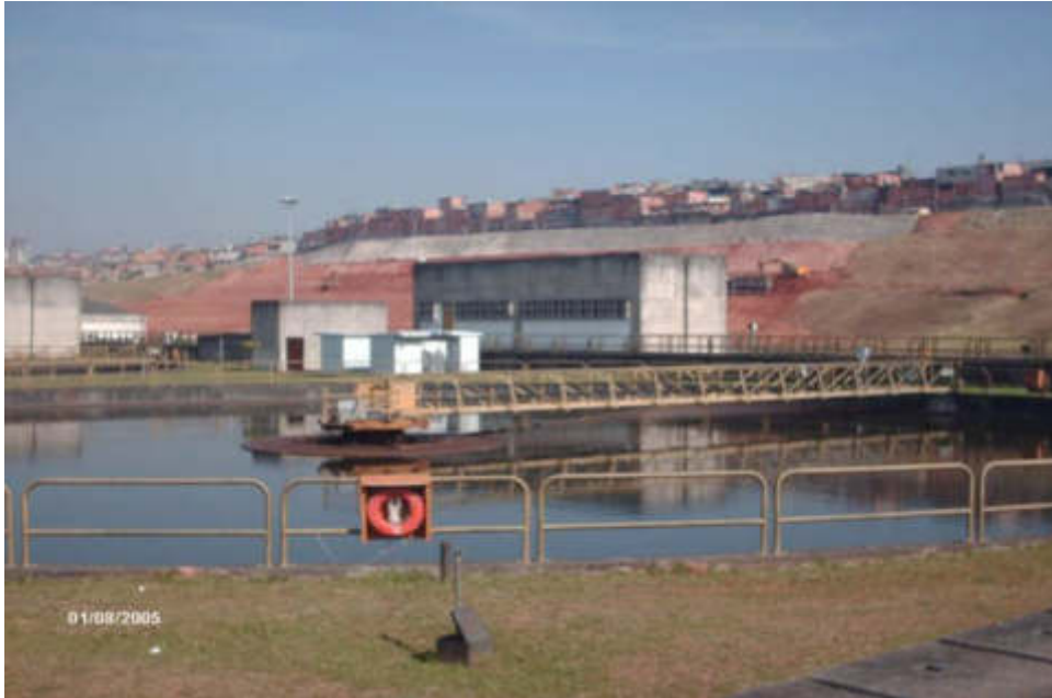
Figura 95 - Vista de um decantador secundário da ETE ABC
