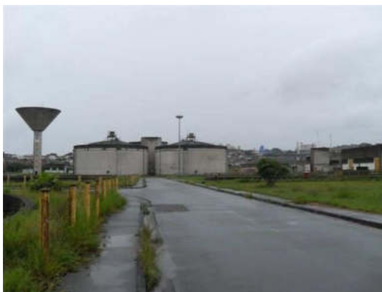
Figura 97 - Vista dos digestores anaeróbios da ETE ABC
