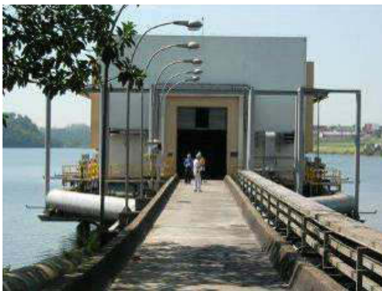
Figura 129 - Estação Elevatória/Casa de Bombas
