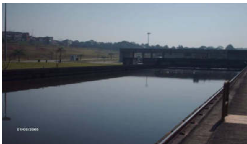
Figura 93 - Vista de um decantador primário da ETE ABC
