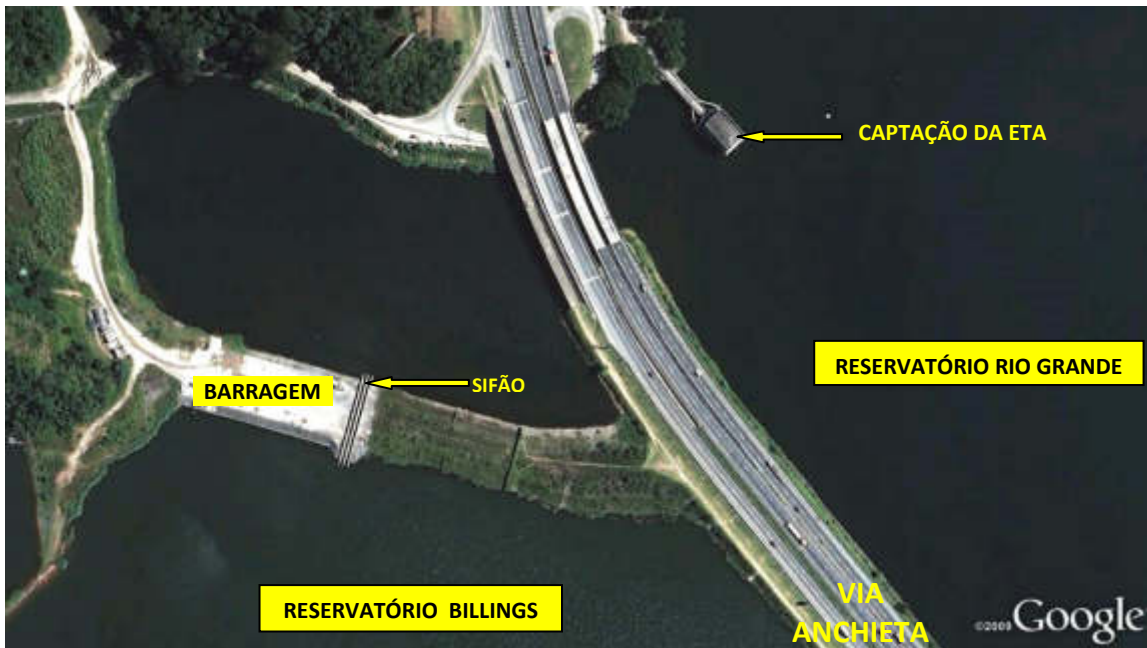
Figura 20 - Ortofoto com localização da Via Anchieta próximo à barragem que separa os reservatórios, e captação para a ETA Rio Grande
