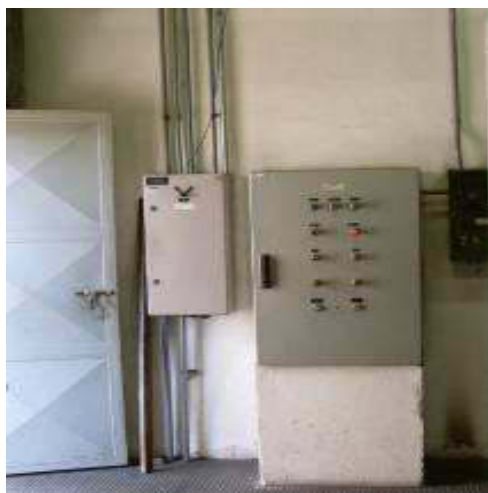
Figura 173 - Acima: Painel de Controle, Entrada em 440 V e Acionamentos dos Conjuntos de 200 CV. Abaixo: Quadros Auxiliares e de Controle
