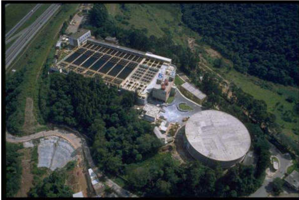
Figura 63 - Vista geral dos floculadores que compõem a “Ala Velha” e “Ala Nova”
