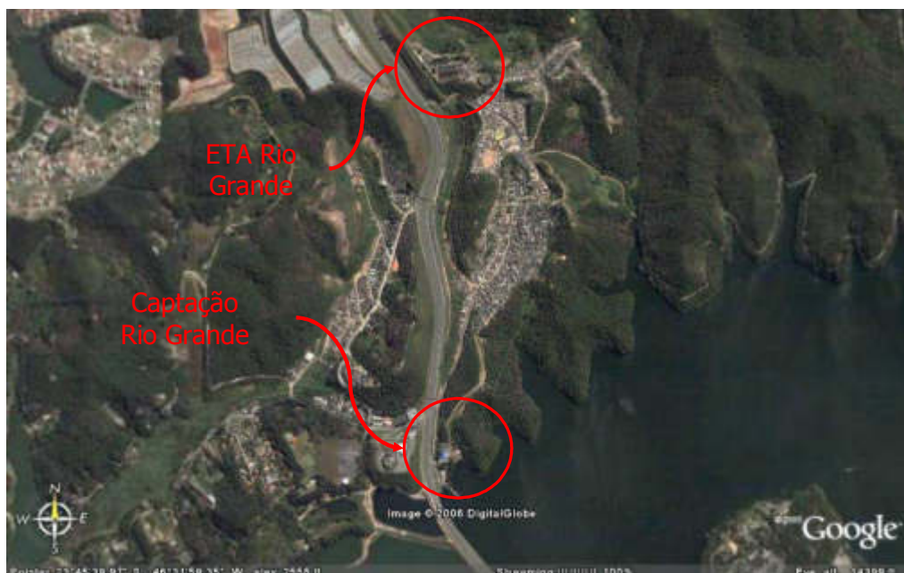
Figura 56 - Vista geral da captação de água bruta no Reservatório Rio Grande em relação a ETA Rio Grande
