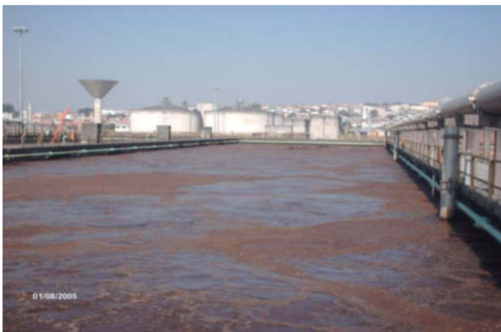
Figura 94 - Vista de um tanque de aeração da ETE ABC
