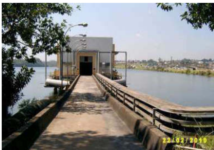
Figura 27 - Vista geral da elevatória de água bruta pertencente a ETA Rio Grande
