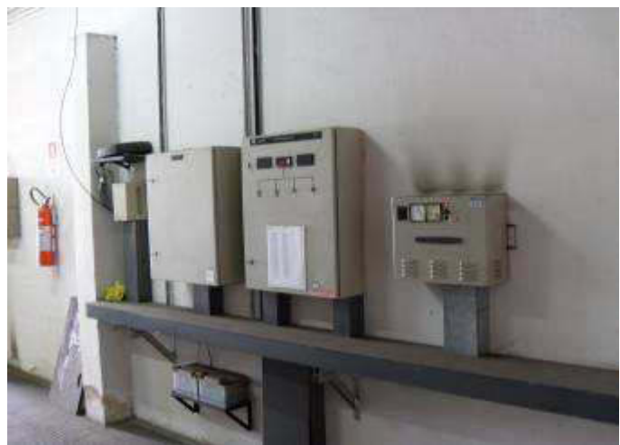
Figura 173 - Acima: Painel de Controle, Entrada em 440 V e Acionamentos dos Conjuntos de 200 CV. Abaixo: Quadros Auxiliares e de Controle
