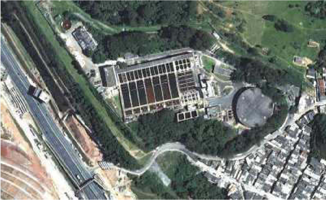
ETA Rio Grande e reservatório principal, à direita na foto acima
