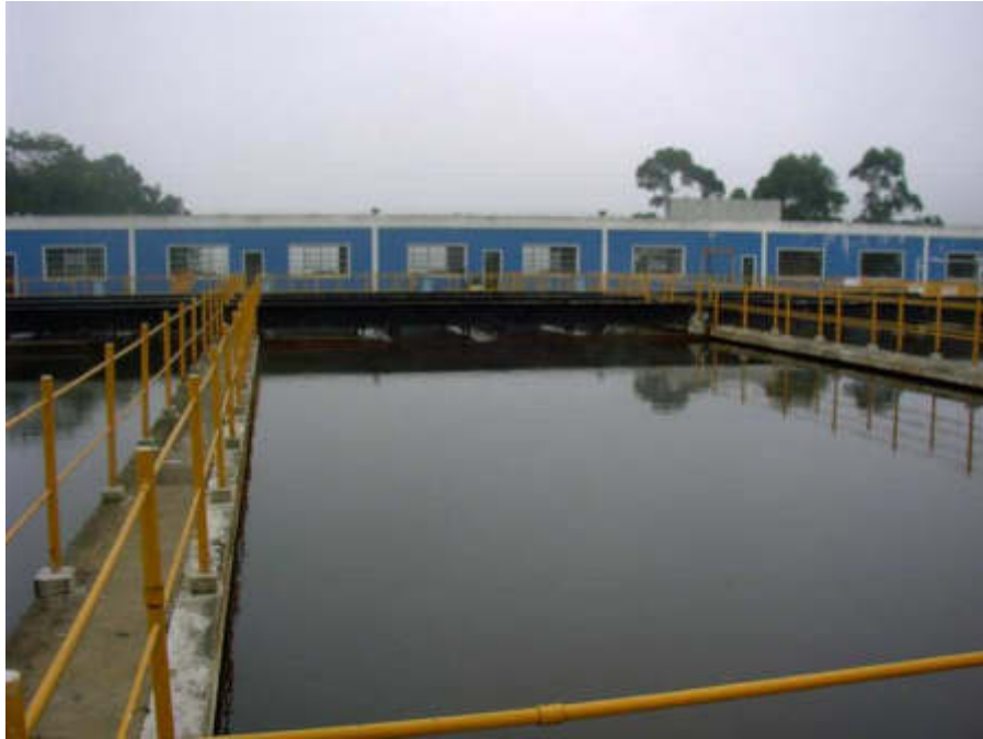
Figura 69 – Vista dos decantadores que compõem a “Ala Velha”
