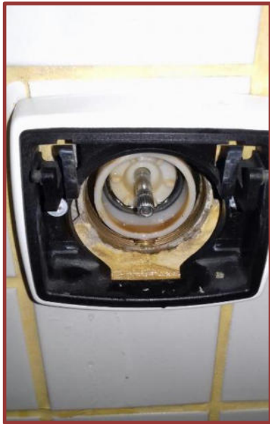
Figura 12 – Reparo e regulagem de válvula de descarga em unidade escolar
