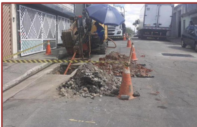
Figura 1: Perfuratriz utilizada na substituição das redes d'água
