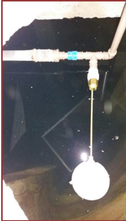
Figura 14 – Substituição de torneira de boia em unidade escolar
