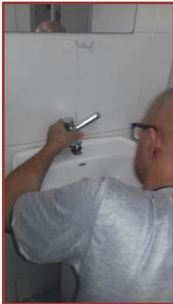
Figura 8 – Instalação de torneira de fechamento automático tipo mesa em unidade de saúde
