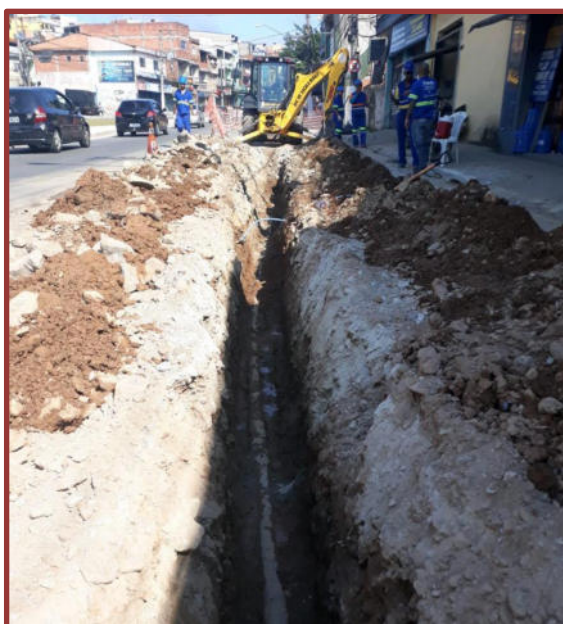
Figura 2: Substituição de rede de água – método destrutivo
