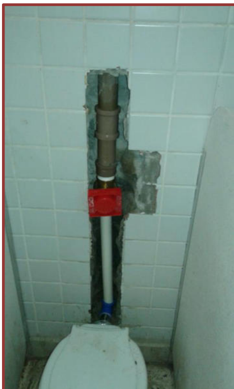
Figura 15 – Substituição de válvula de descarga em unidade esportiva
