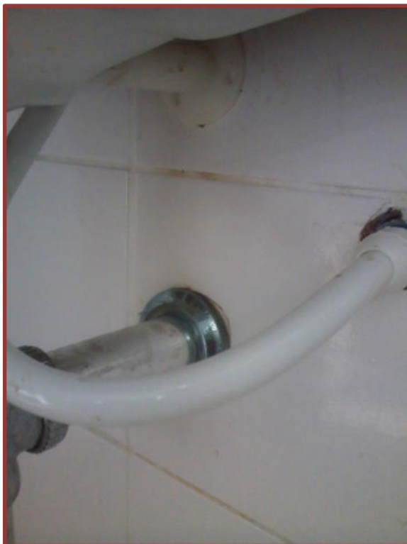
Figura 13 – Substituição de engate flexível de lavatório em unidade de saúde
