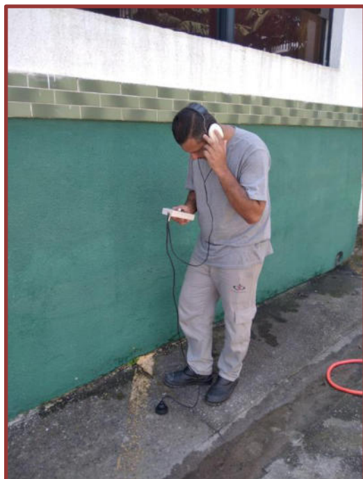
Figura 9: Geofonamento em próprio municipal
