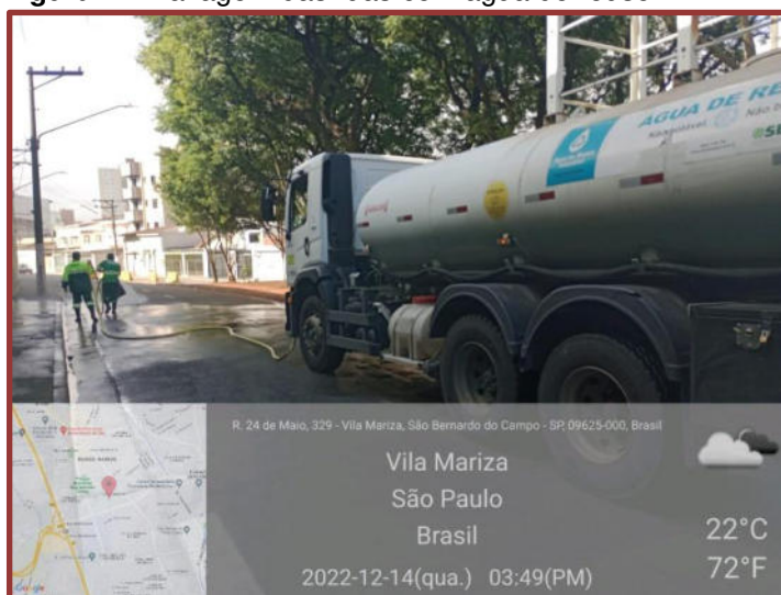
Figura 17- Lavagem das ruas com água de reúso
