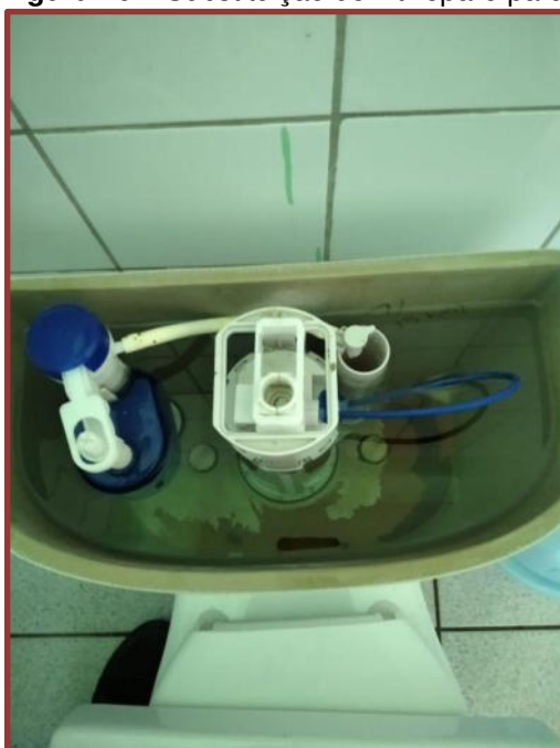
Figura 10 – Substituição de kit-reparo para caixa acoplada em unidade educacional
