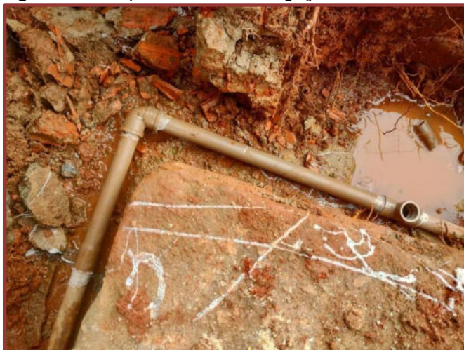
Figura 11 – Reparo de ramal de ligação em uma unidade administrativa
