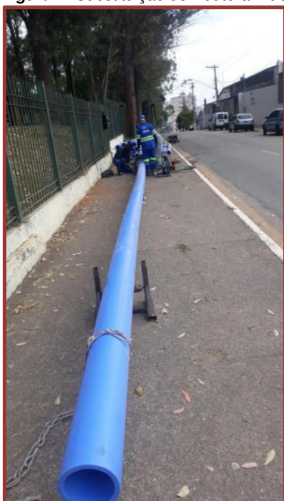
Figura 4: Substituição de Adutora: Tubulação soldada para ser introduzida no furo
