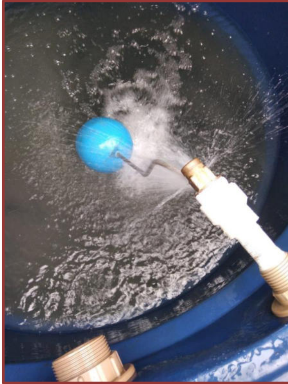
Figura 12 – Substituição de torneira de boia em unidade esportiva
