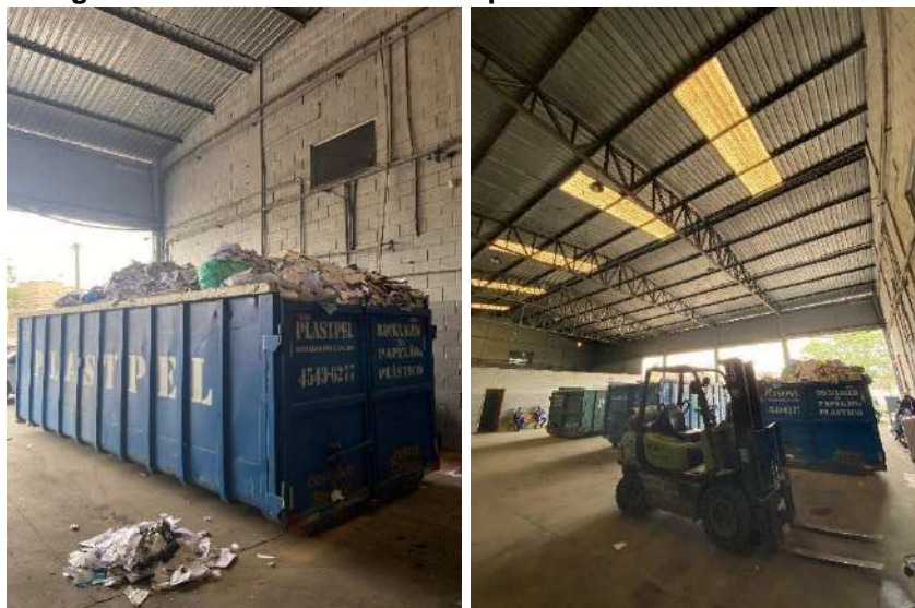
Figura 90: Contêineres dos compradores com material solto.
