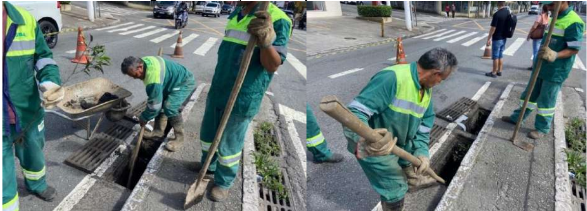
Figura 57: Serviços de Limpeza de Bocas-de-lobo.
