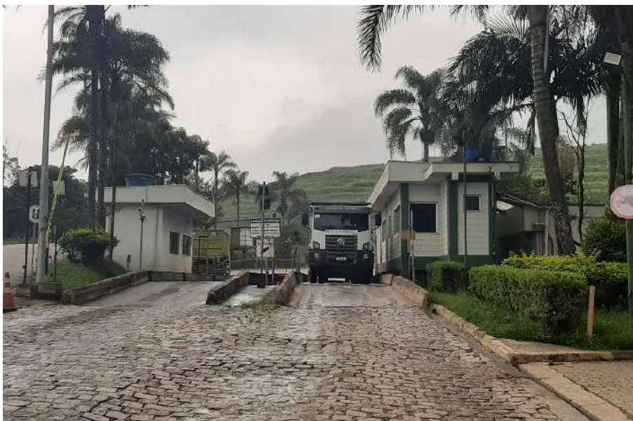
Figura 113: Balança do Aterro Sanitário LARA.
