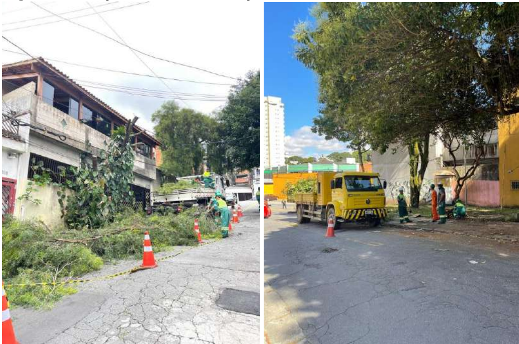
Figura 53: Serviços de Poda em execução Rua Romildo Ceola e Av. João Firmino.
