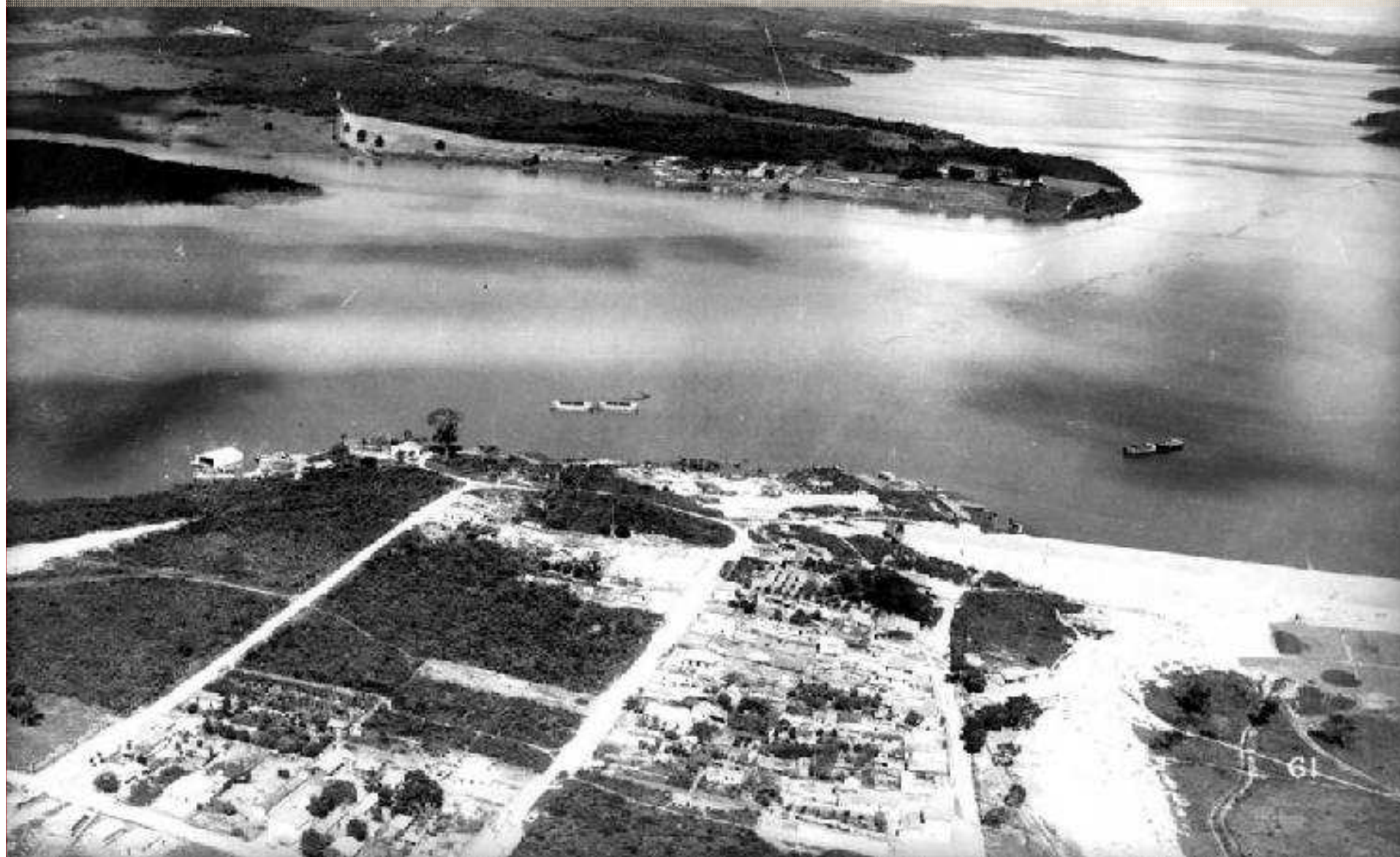
Vista Geral do Reservatório Billings durante seu enchimento, próximo da barragem da
