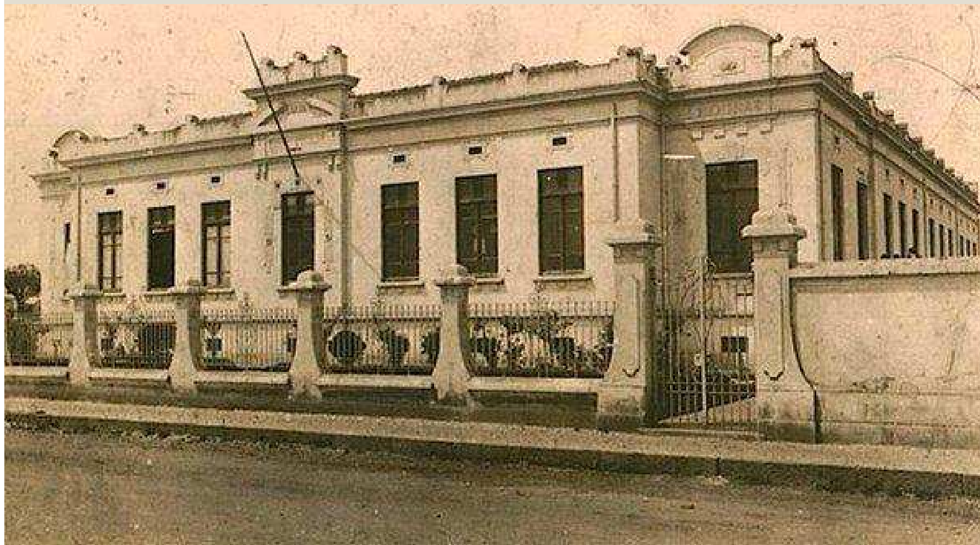
1º Grupo Escolar de São Bernardo, inaugurado em 1914 próximo à estação de mesmo nome
