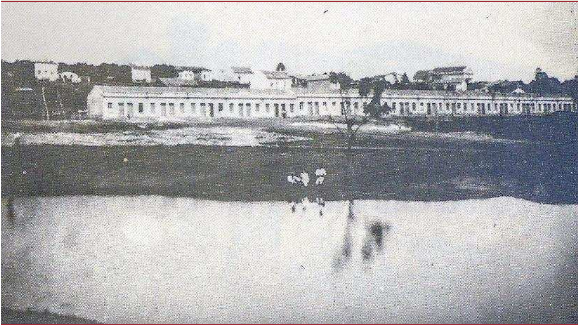
Conjunto de casas operárias da Fábrica Ypiranguinha, Bairro da Estação São Bernardo (hj, Santo André)
