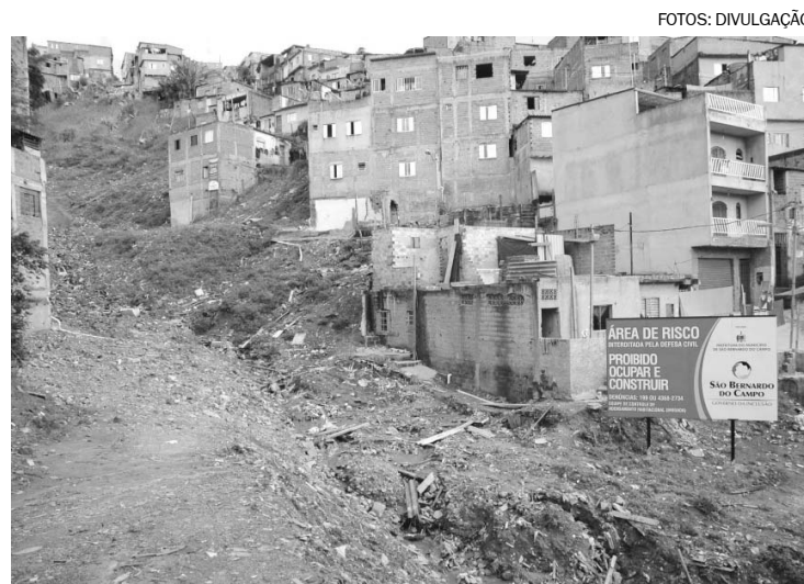
Moradores de áreas com incidência de deslizamentos receberão assistência
