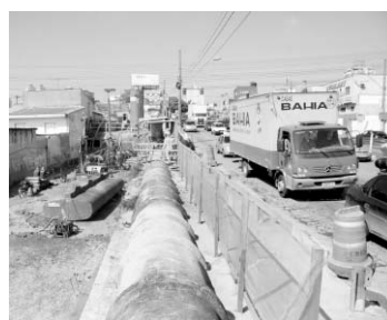
Obra permitirá maior fluidez
